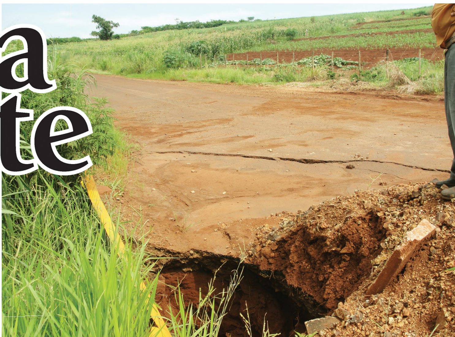
Ponte da vicinal Lauro Perazzoli que cedeu com as chuvas e precisou ser interditada
