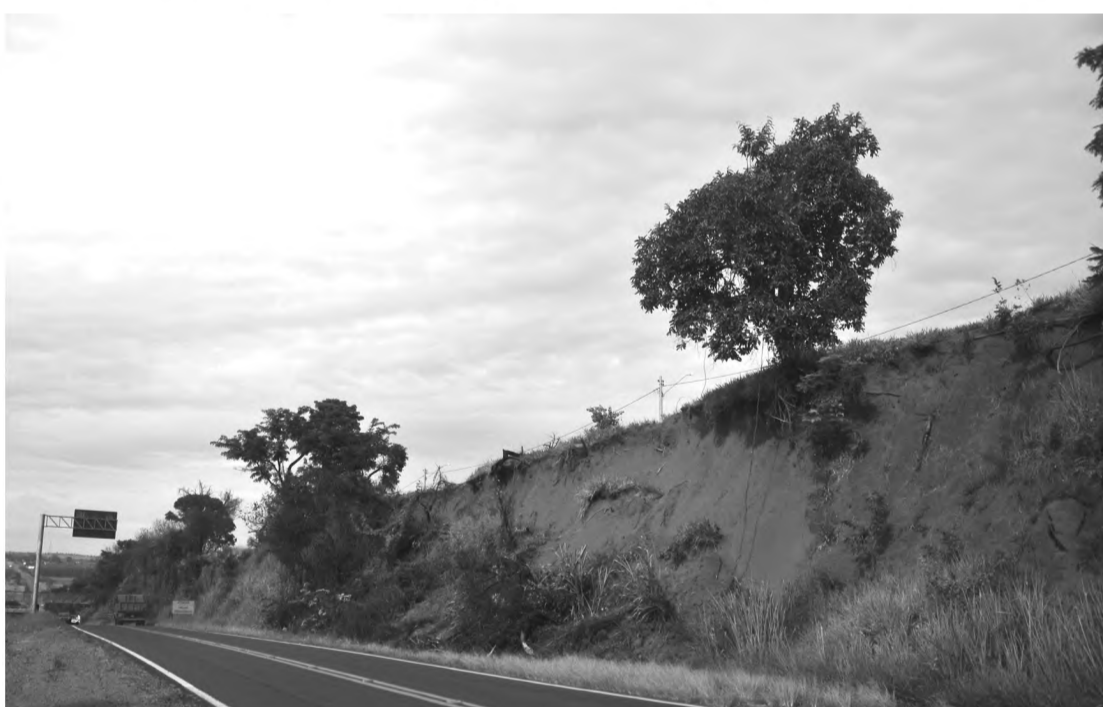
Local em que a terra cedeu e ocupou acostamento da rodovia Osny Matheus
