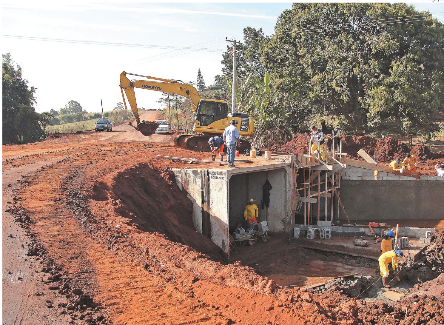
Obras para canalização da água sob a vicinal Lauro Perazolli estão quase prontas, diz empreiteira
