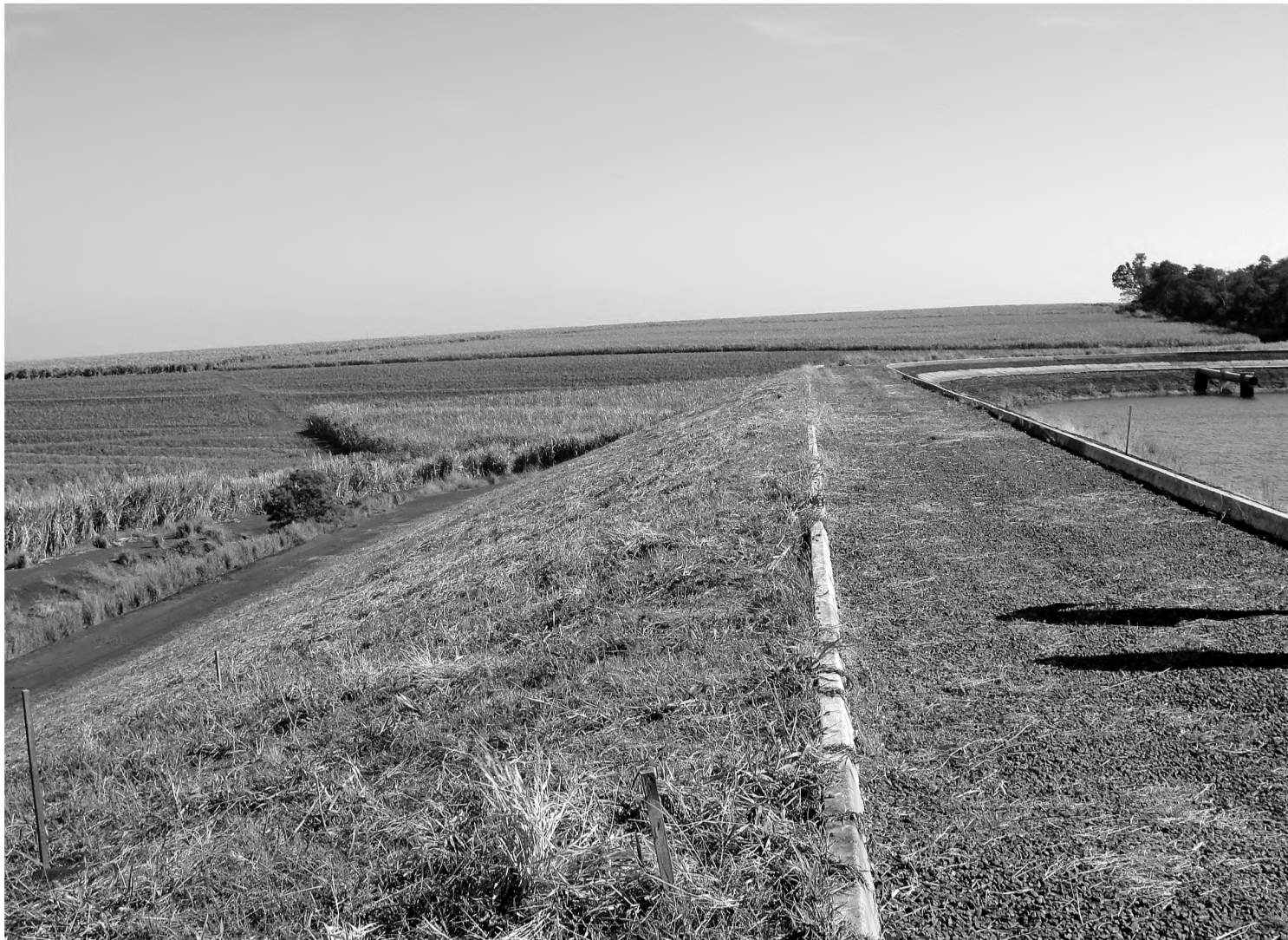
Vazamento em lagoa de tratamento da Estação de Tratamento de Esgoto vai atrasar funcionamento de serviço
