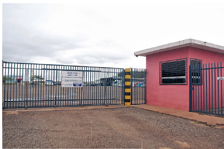
Desde de 2008 na atual sede, com 12 mil metros quadrados
