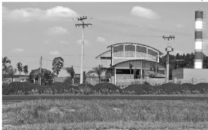
EM OBRAS - Estrutura de apoio está em fase de acabamento
