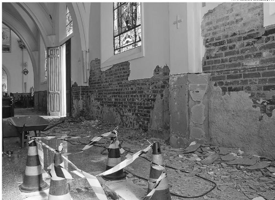
EM REFORMA - Infiltrações obrigaram uma reforma de urgência no Santuário; placas de mármore estão sendo retiradas
