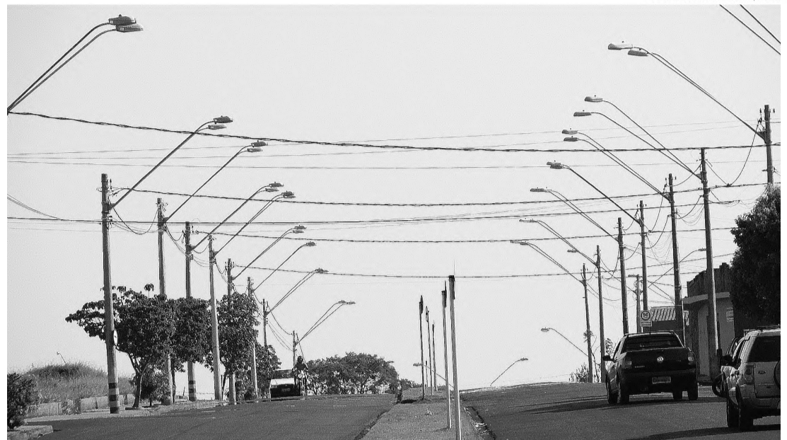
ANO NOVO - Municipalização do serviço de manutenção da iluminação pública começa em janeiro
