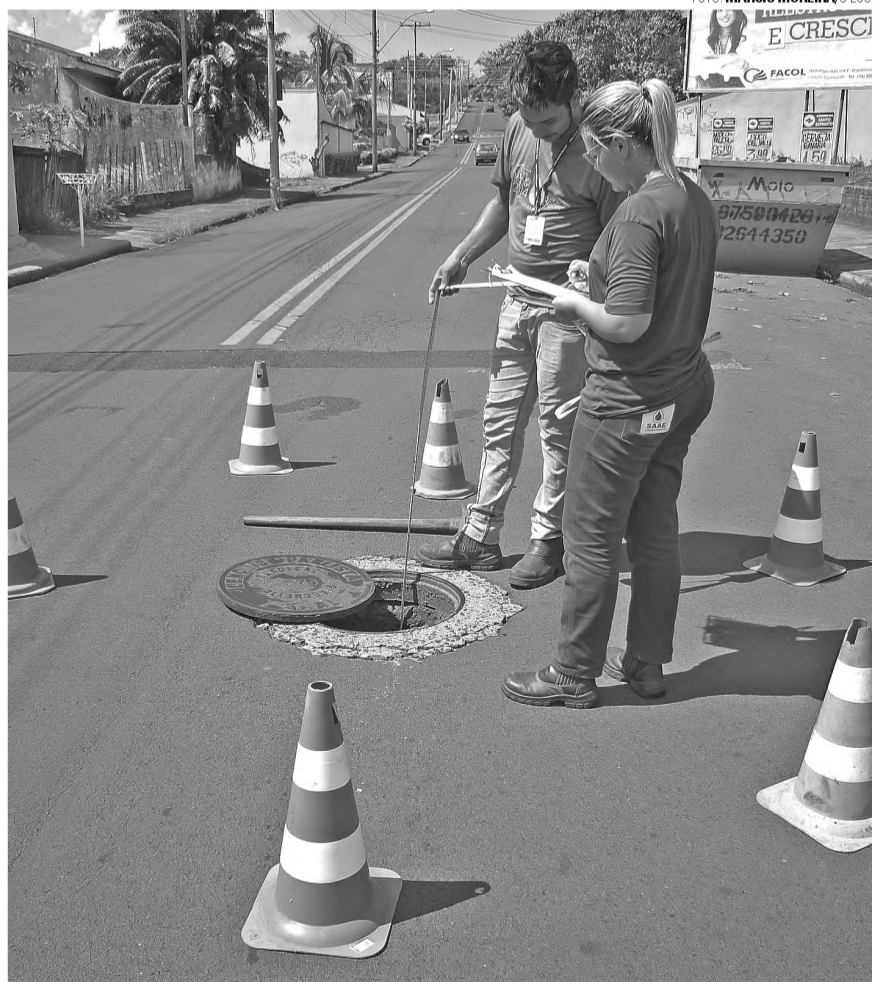
REDE DE ESGOTO - A equipe do SAAE (Serviço Autônomo de Água e Esgoto) de Lençóis Paulista faz um monitoramento diário de toda rede de esgoto da cidade para saber como está a vazão e a captação. Na foto, tirada na tarde de ontem, os técnicos fazem o trabalho na Rua César Giacomini, Vila Santa Cecília.
