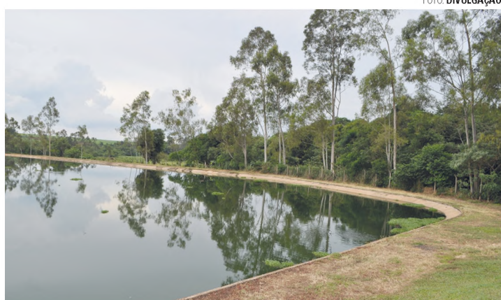
AMBIENTE - Lagoa de Tratamento de Esgoto vai passar por limpeza
