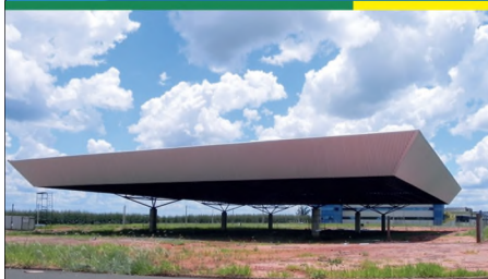
Novo Terminal Rodoviário (Em Construção)
