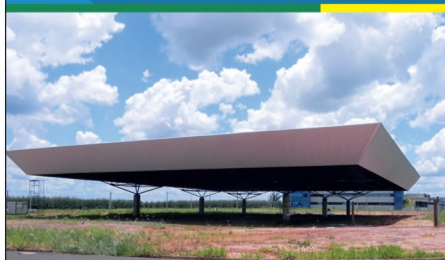
Novo Terminal Rodoviário (Em Construção)
