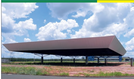
Novo Terminal Rodoviário (Em Construção)
