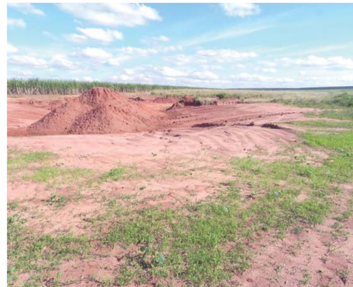
NOVA ÁREA - Terreno para o novo aterro foi doado pela Zilor e fica a 11 quilômetros da cidade
