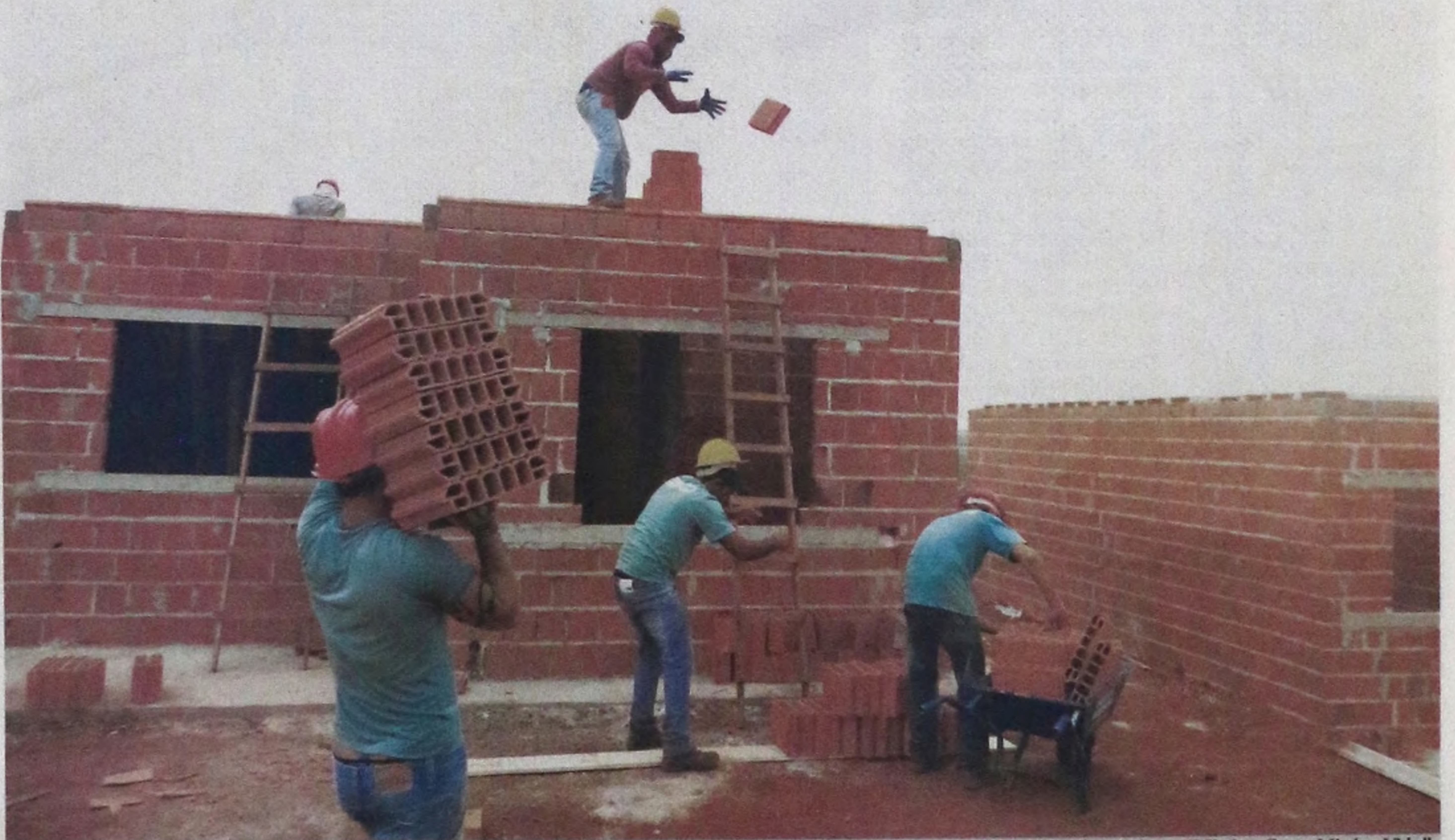
Equipe de colaboradores da construtora Ecovita trabalham no Jardim Carolina para edificar as 452 casas do projeto "Minha Casa Minha Vida"
