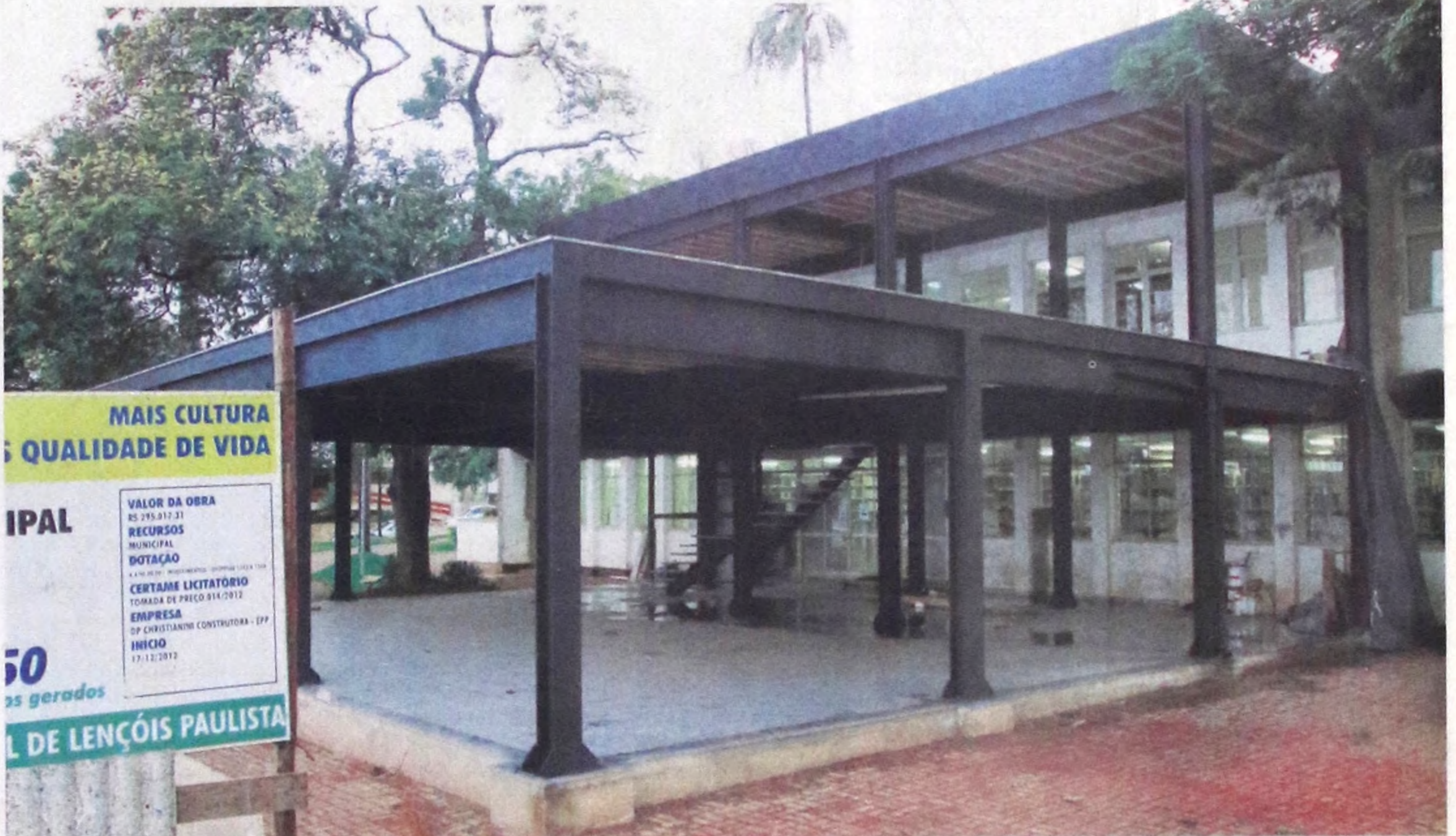
A próxima etapa de finalização será a instalação elétrica e dos vidros, o que deve levar cerca de 40 dias
