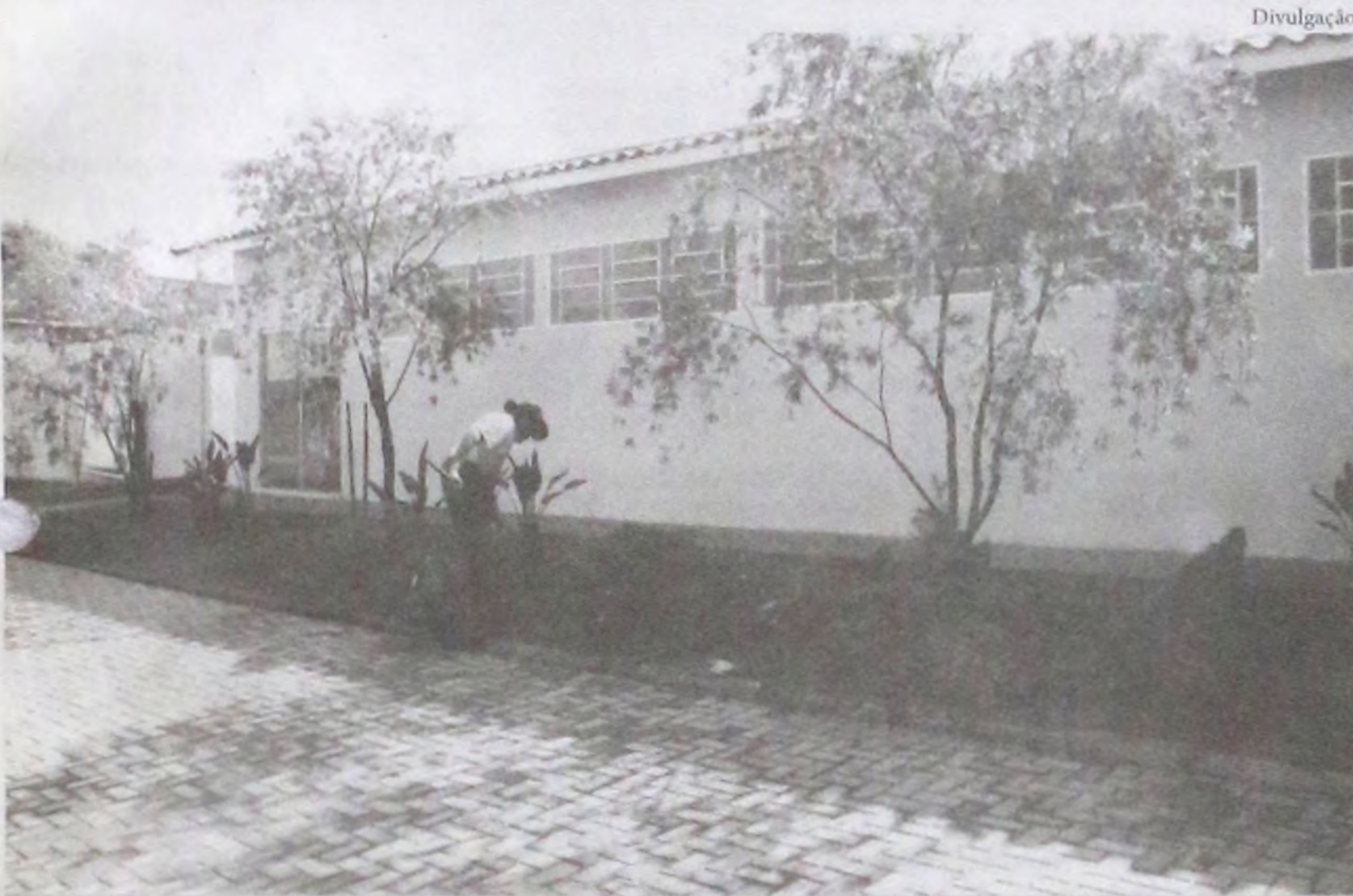
Fachada do ESF no Júlio Ferrari reinaugurado hoje depois de reforma
