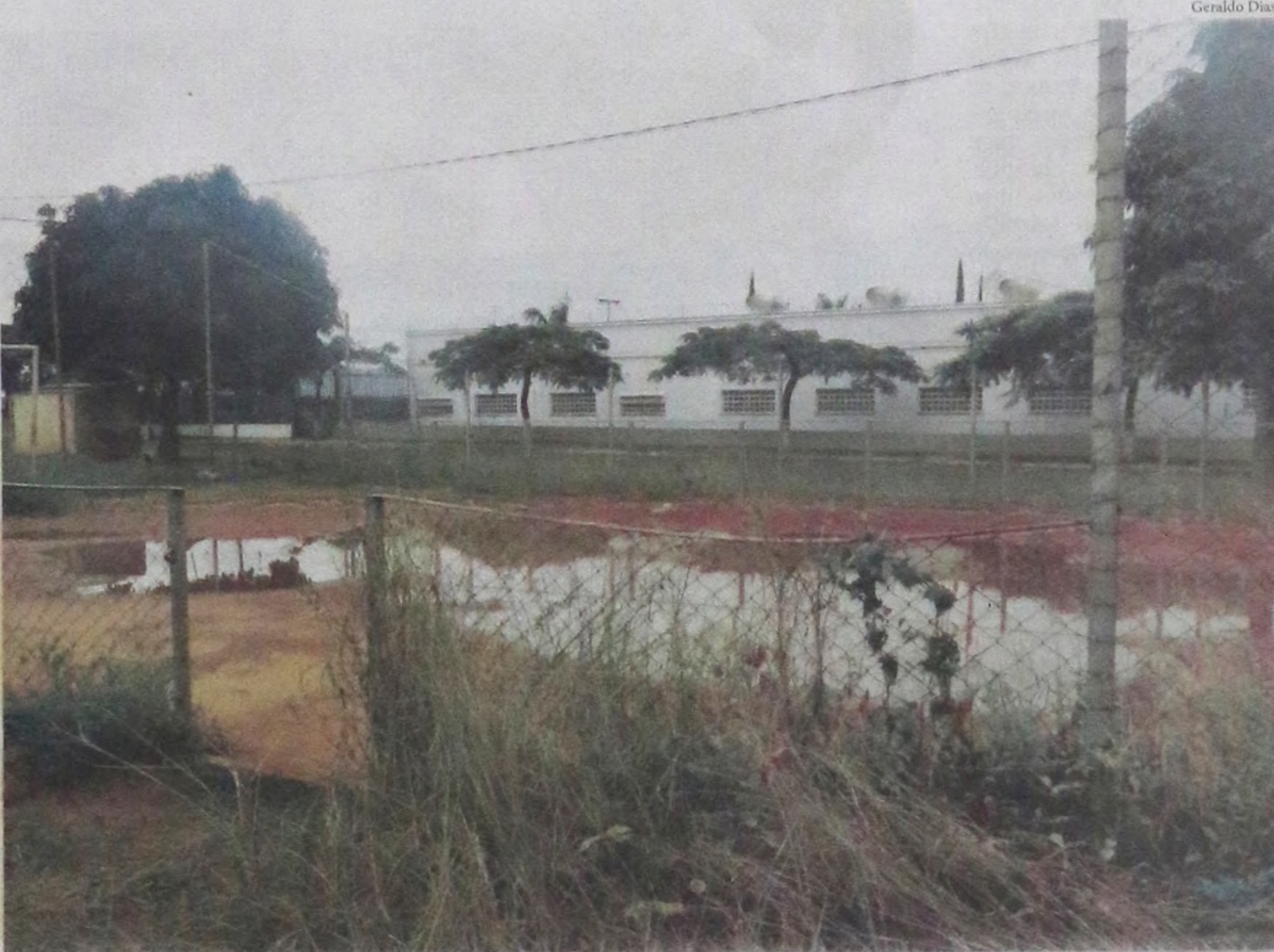
Área do Residencial Atenas abandonada pela Cooperativa COOPERVAP, responsável pela administração
