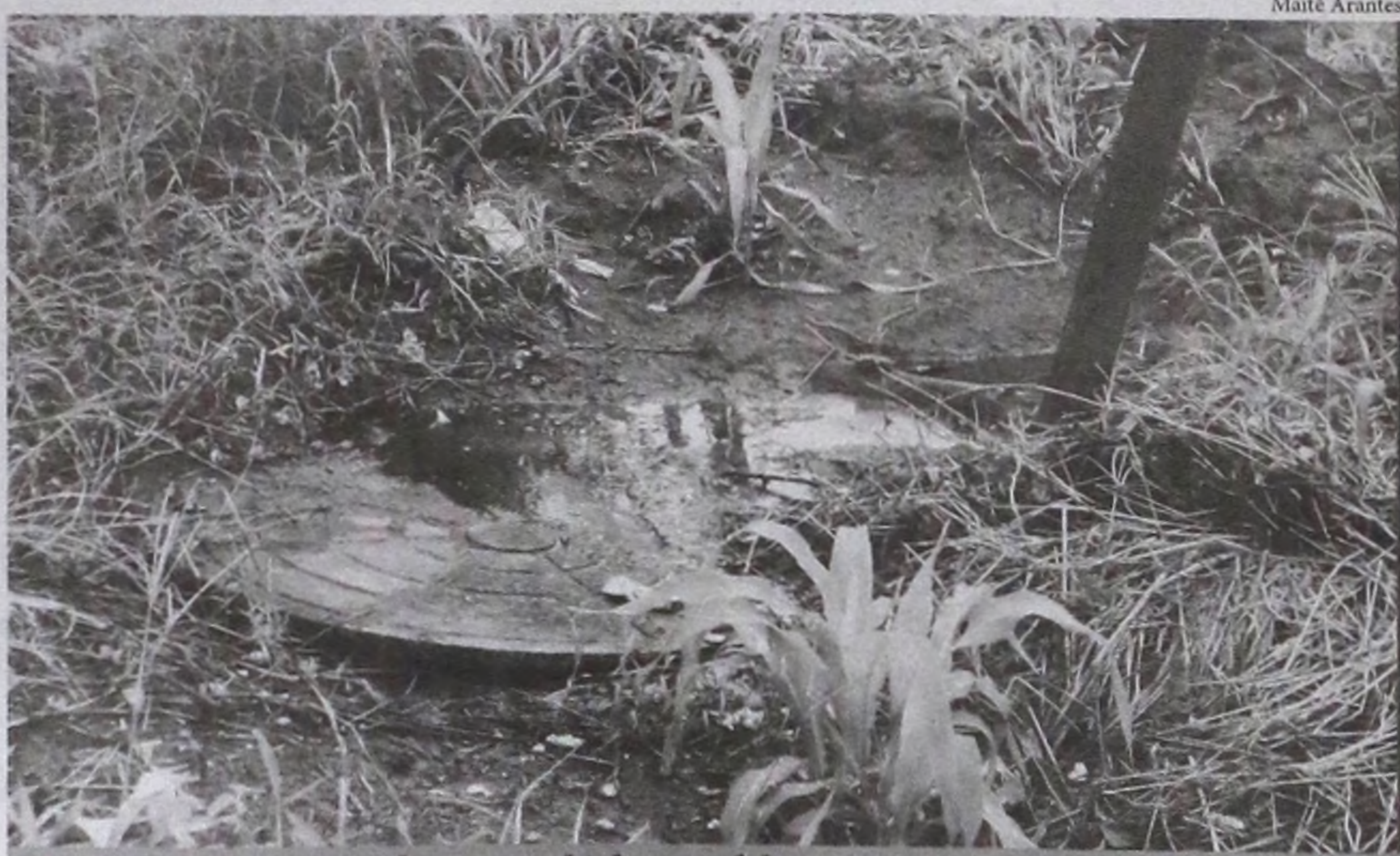
Mato alto, elevatório de esgoto, bichos, asfalto precário são alguns dos problemas
