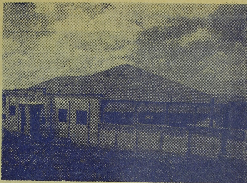
Novo Matadouro Municipal, inaugurado no dia 28/4/58
