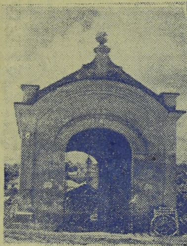
Velho Matadouro Municipal à rua Tibiriçá, prestes a ser Demolido
