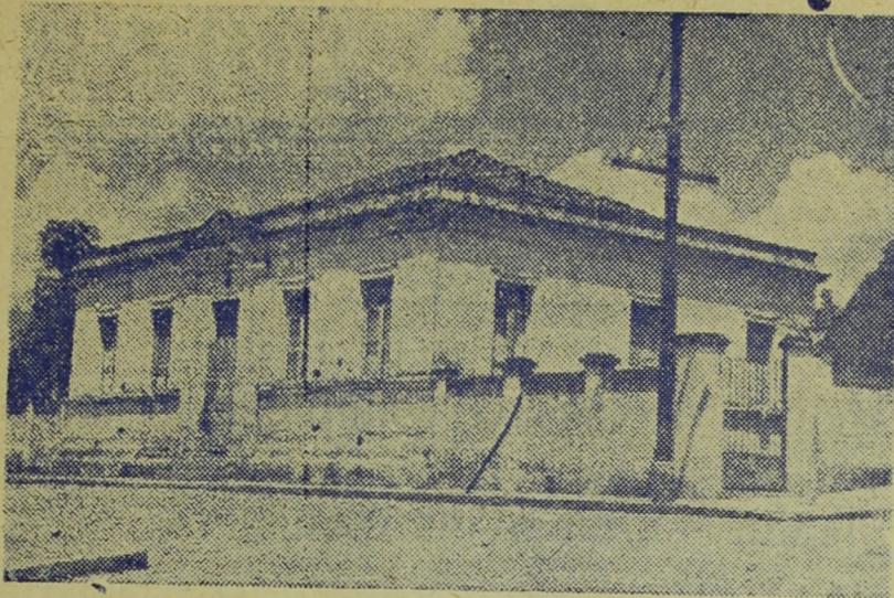
Predio da Velha Cadeia Publica em fase de Demolição.
