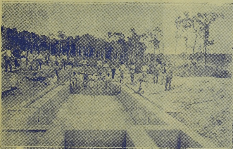
Primitivo Reservatorio do abastecimento de Agua à cidade, no Marimbondo
