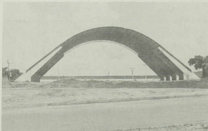
Ginásio de Esportes em Construção.
