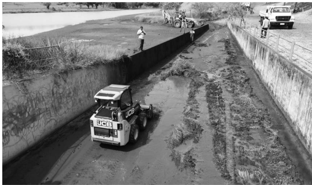
LIMPEZA - Trabalho contemplou a retirada de lixo e entulho acumulados nas margens do lago e retirada de lodo e sujeira que se formaram no fundo do canal
