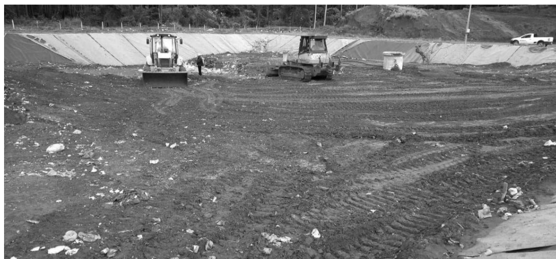
ATERRO - Local está operando há dois anos e está com 15% de sua capacidade ocupada em uma das duas valas
