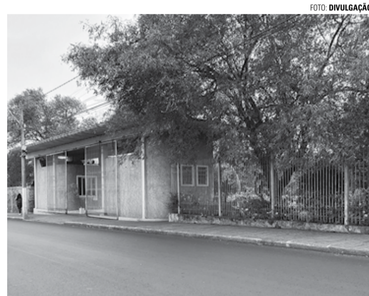
MÁ CONSERVAÇÃO - CEC tem mato alto, piscinas sujas e construções destelhadas
