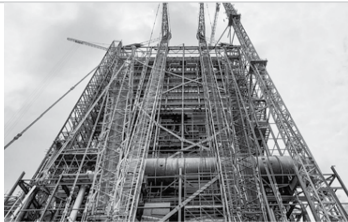
PREPARATIVOS - Procedimento está sendo feito nas tubulações da caldeira de recuperação e consiste na injeção de vapor de alta pressão
