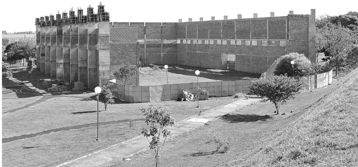
TUDO PARADO - Construção do ginásio Edermizão já foi interrompida três vezes
