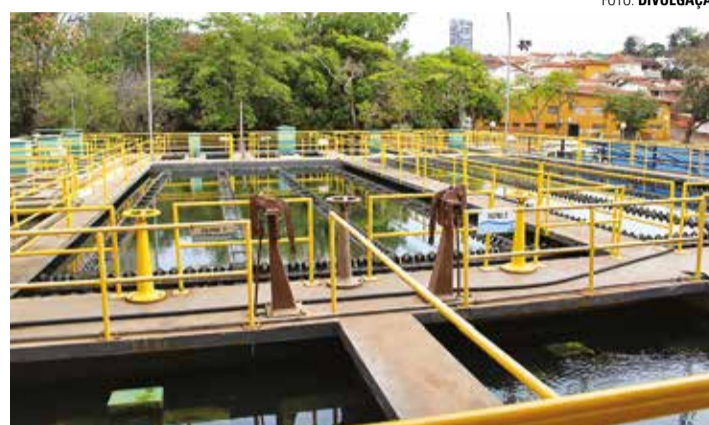
MELHORIAS - SAAE está realizando diversas ações para melhorar o abastecimento e tratamento de água na cidade
