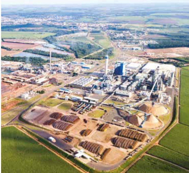
PROJETO STAR - Construção da nova unidade empregou mais de 13 mil trabalhadores no pico de implantação
