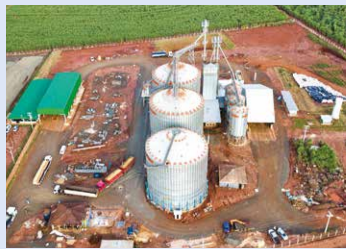
PRODUÇÃO EM ALTA - Novos silos da Camda têm capacidade para armazenar 420 mil sacas de grãos
