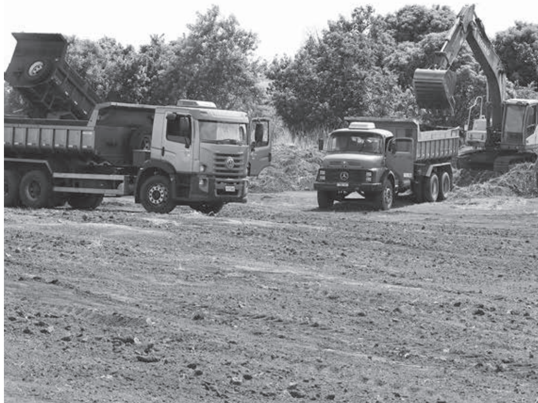
COMEÇOU - Etapa de infraestrutura teve início nesta semana e deve se concluir até o final do ano
