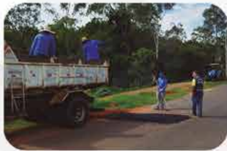
PREFEITURA DE BOREBI REALIZA RECAPE NA RODOVIA DA AMIZADE
