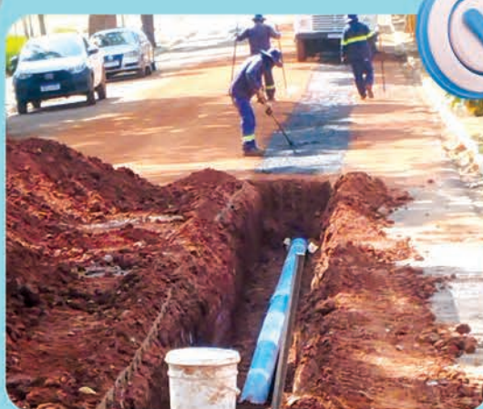
Obra adutora Rua Coronel Álvaro Martins
