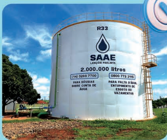
Poço e reservatório CECAP (em finalização)
