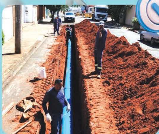
Obra adutora Jardim Ubirama
