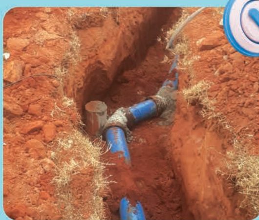
Obra adutora Avenida Prefeito Jácomo Nicolau Paccola
