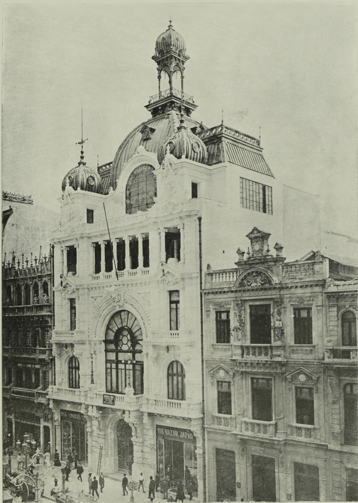
Edifício da séde social a inaugurar-se amanhã, 7, 29º anniversario da sua fundação
