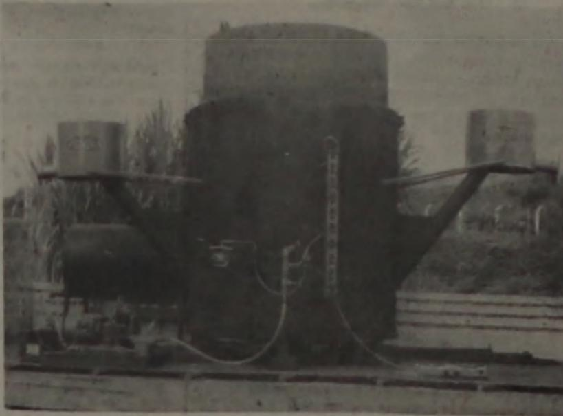
Na foto acima, a unidade de demonstração do Biodigestor, modelo indiano, fabricado pela Penha, que na oportunidade acionava: 1 fogão doméstico, um motor gerador de energia elétrica, lâmpadas de 60 watts e lampião.
