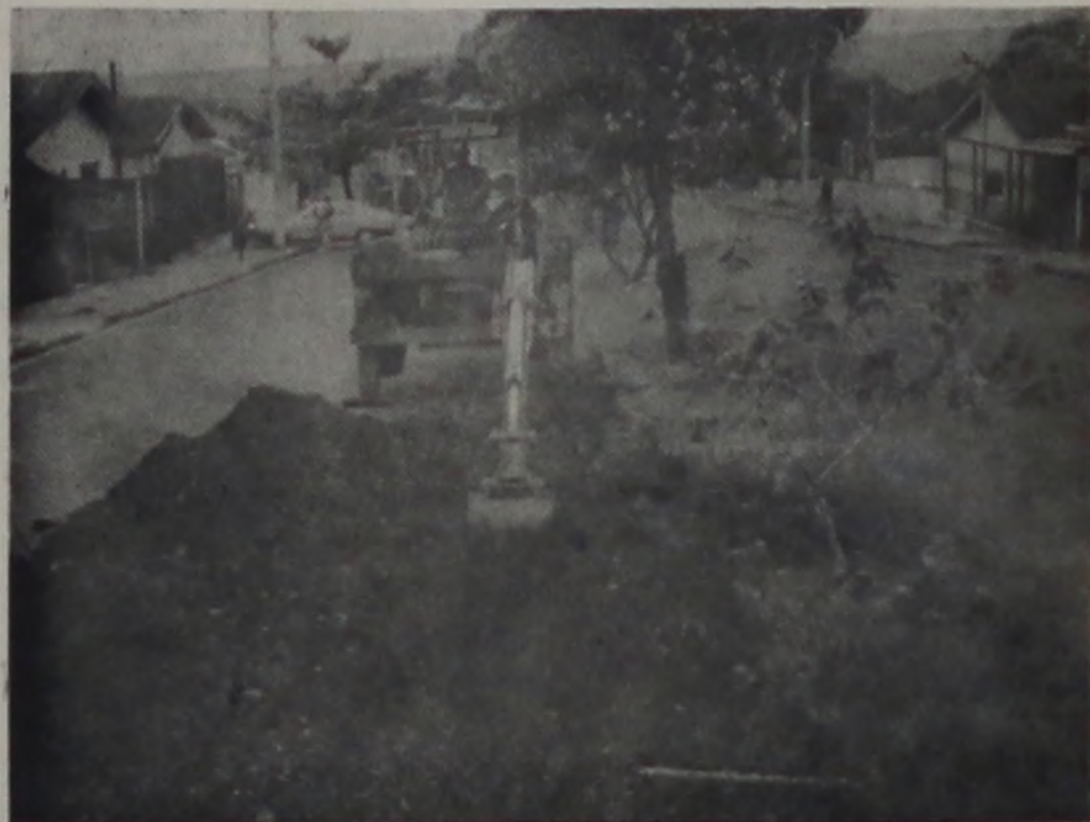
Preparação para implantação da rede adutora através da Av. Padre Salústio Rodrigues Machado para interligação com a rede da Vila Cachoeirinha.
