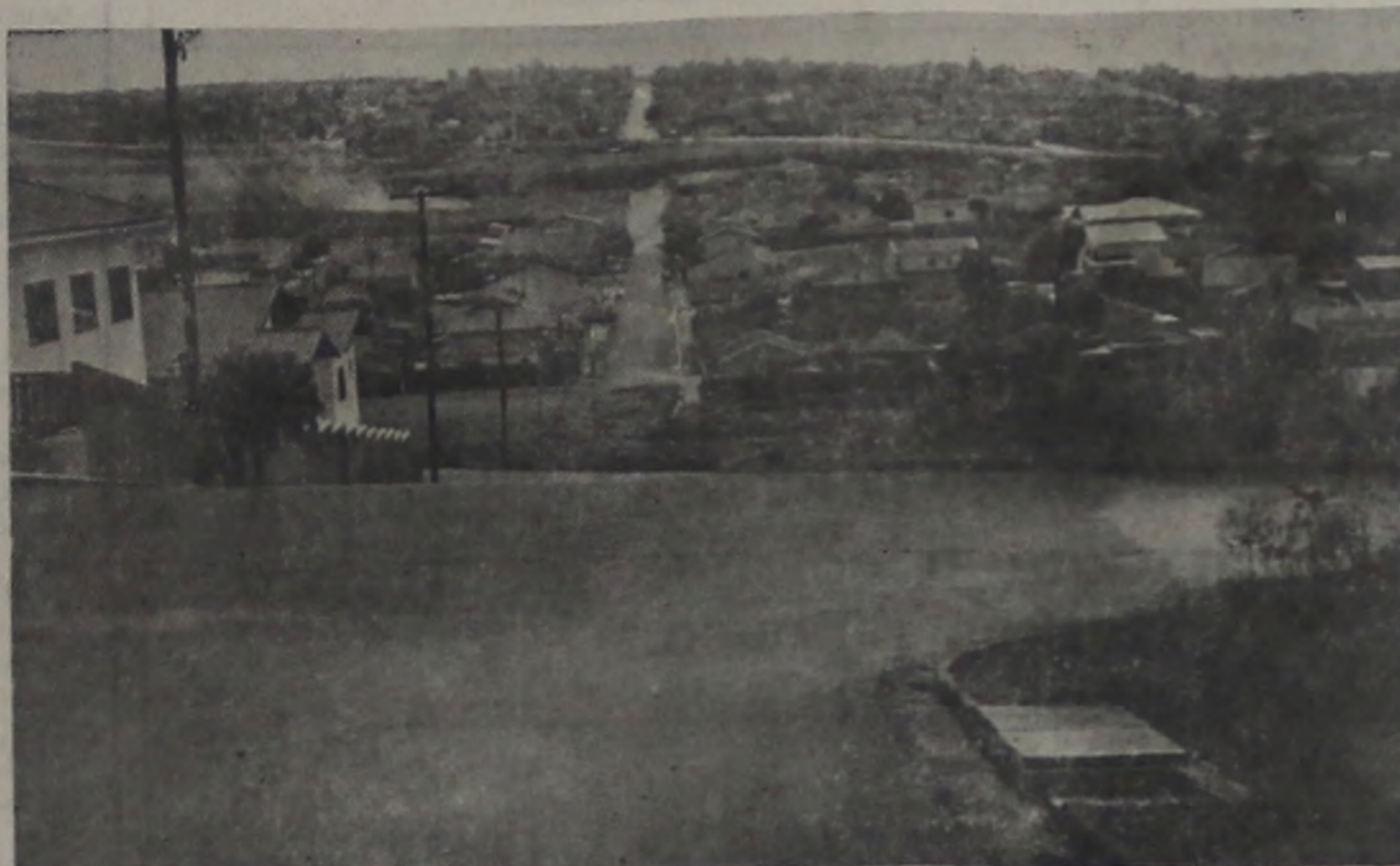
A Rua 28 de Abril será agora um importante corredor de circulação.
