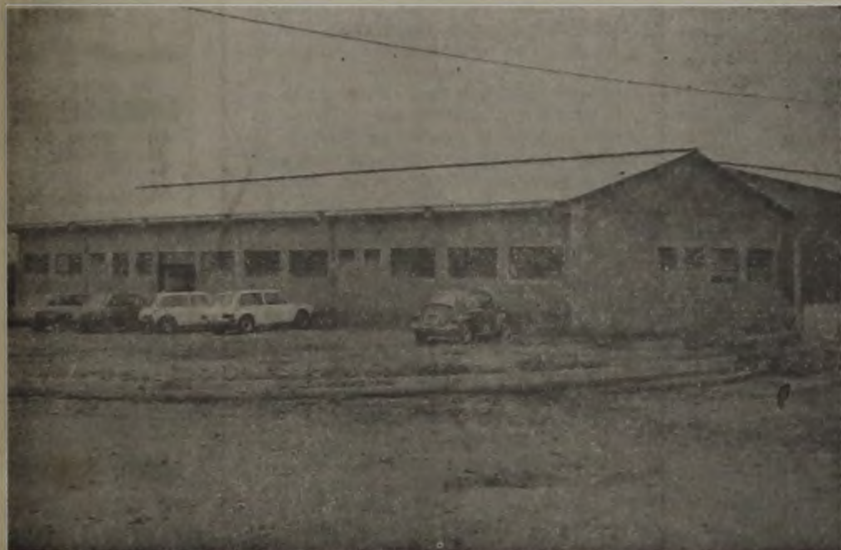
ATRAVÉS DE CONVENIOS A PREFEITURA CUIDARÁ DA REDE FÍSICA E PODERÁ ATE MESMO CONSTRUIR PRÉDIOS ESCOLARES COMO ACONTECEU EM 87
