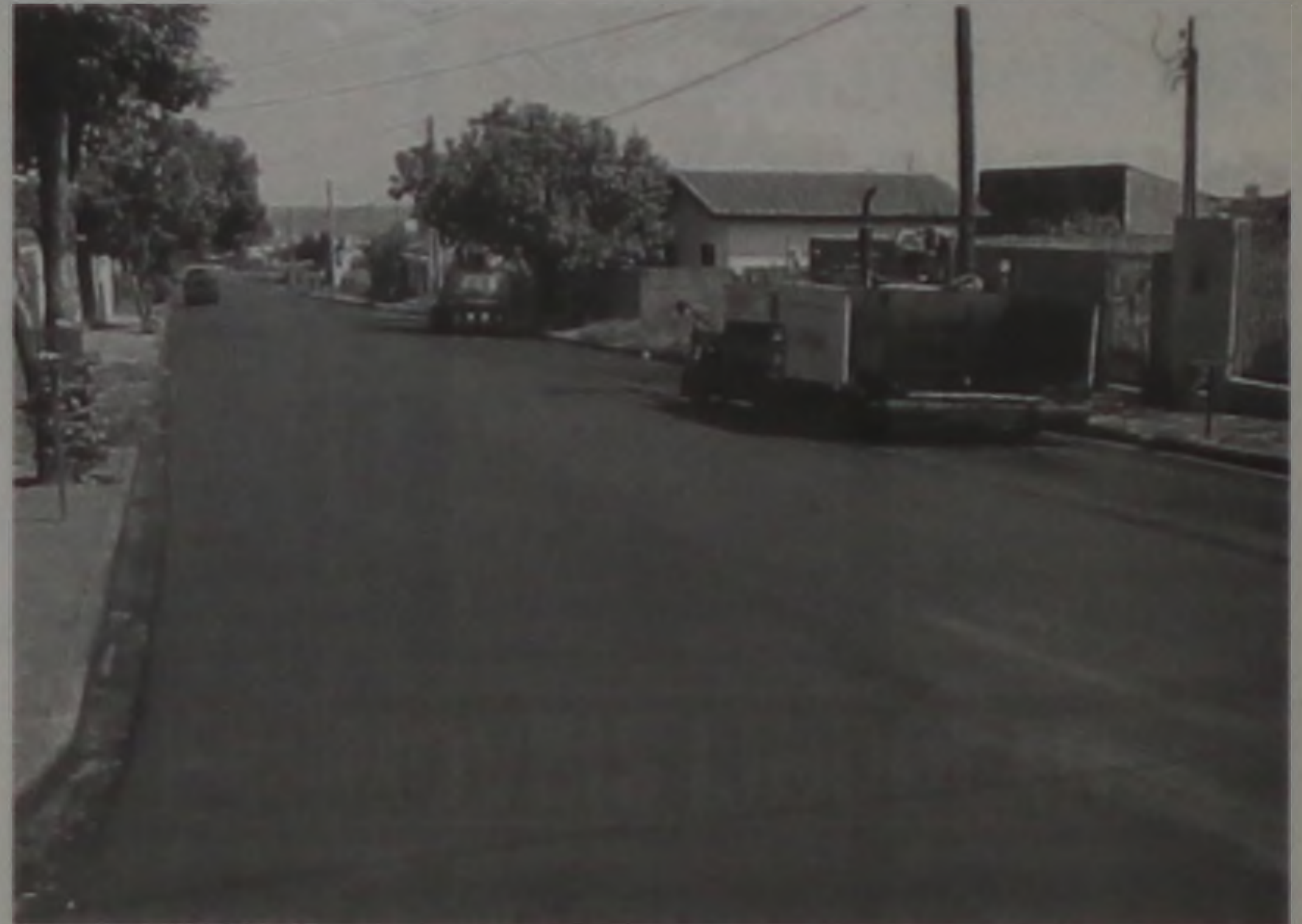
Conclusão do asfalto no Parque Rondon
