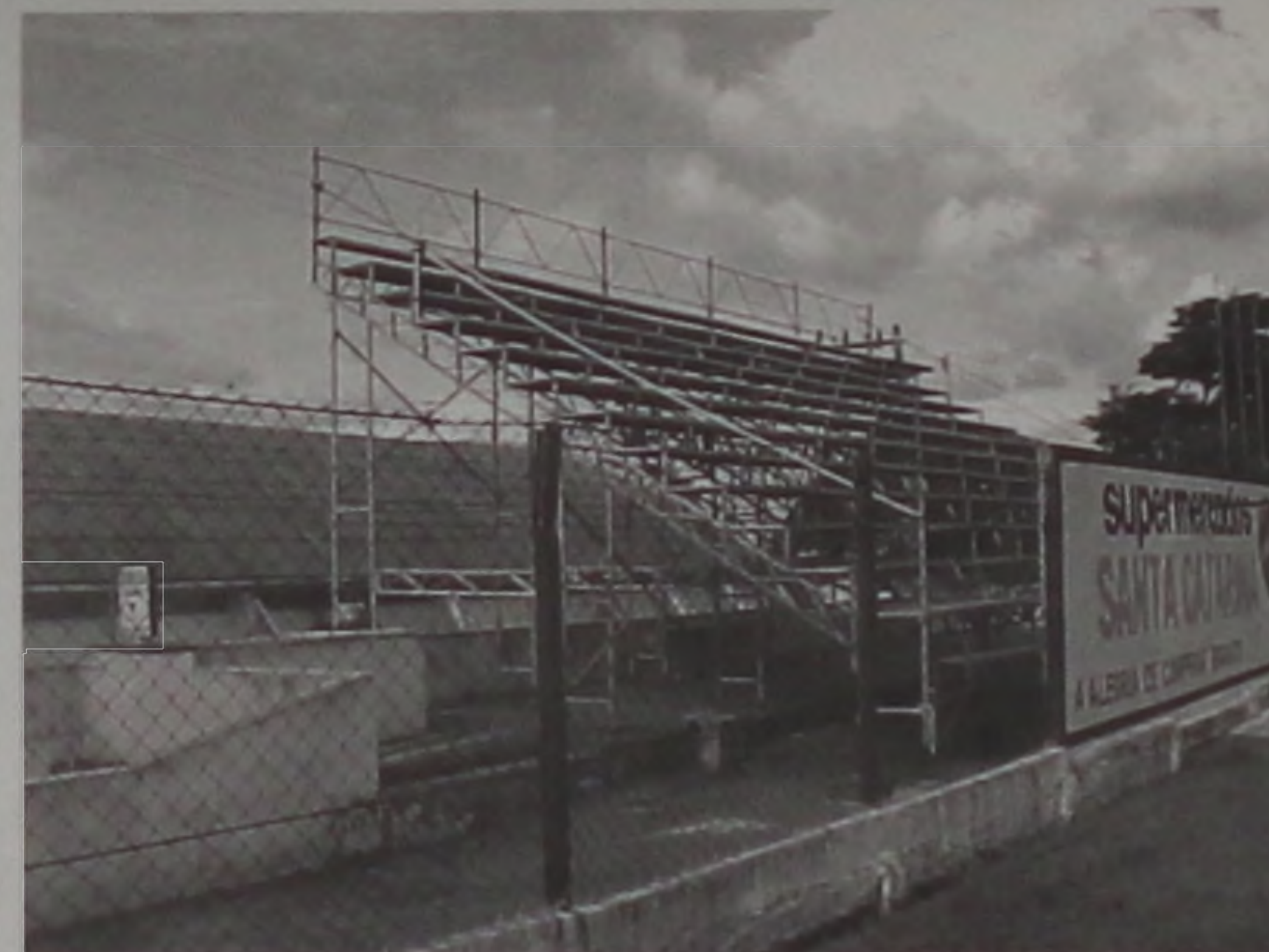
Arquibancadas improvisadas no Bregão
