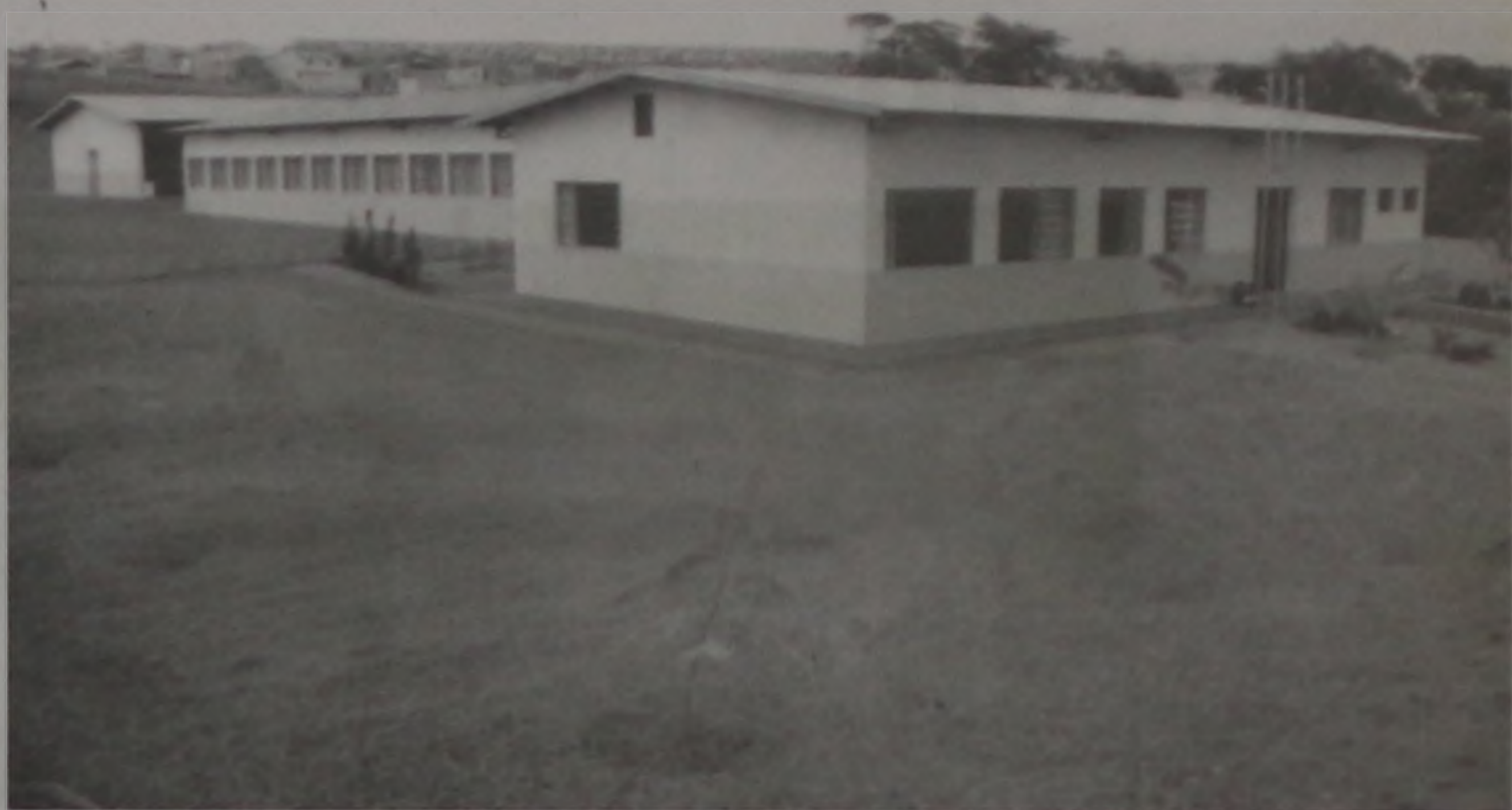
Amplio espaço das instalações da escola Municipal "Prof. Nelson Brollo no Monte Azul
