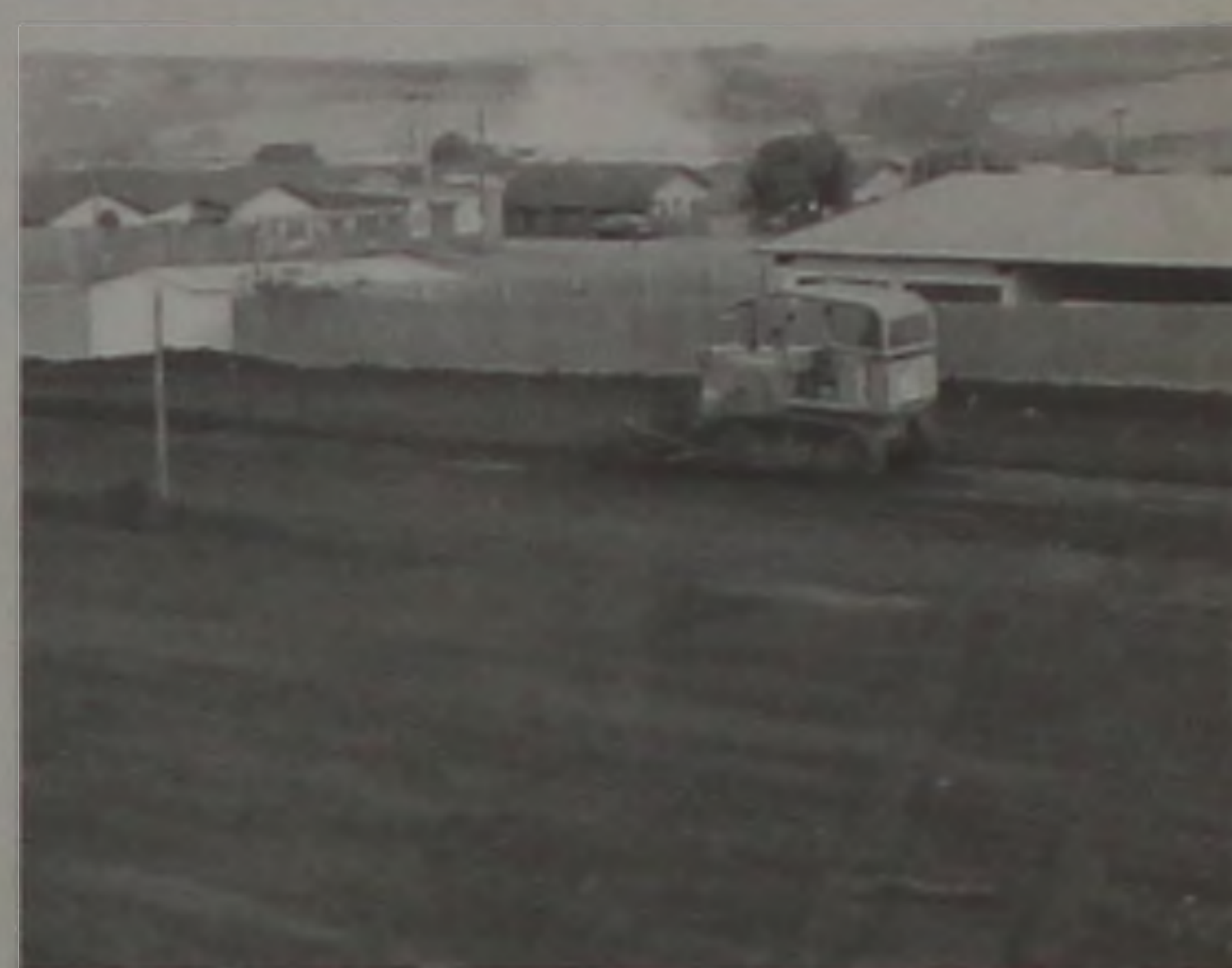
Máquina trabalha na terraplanagem que abrigará a quadra
