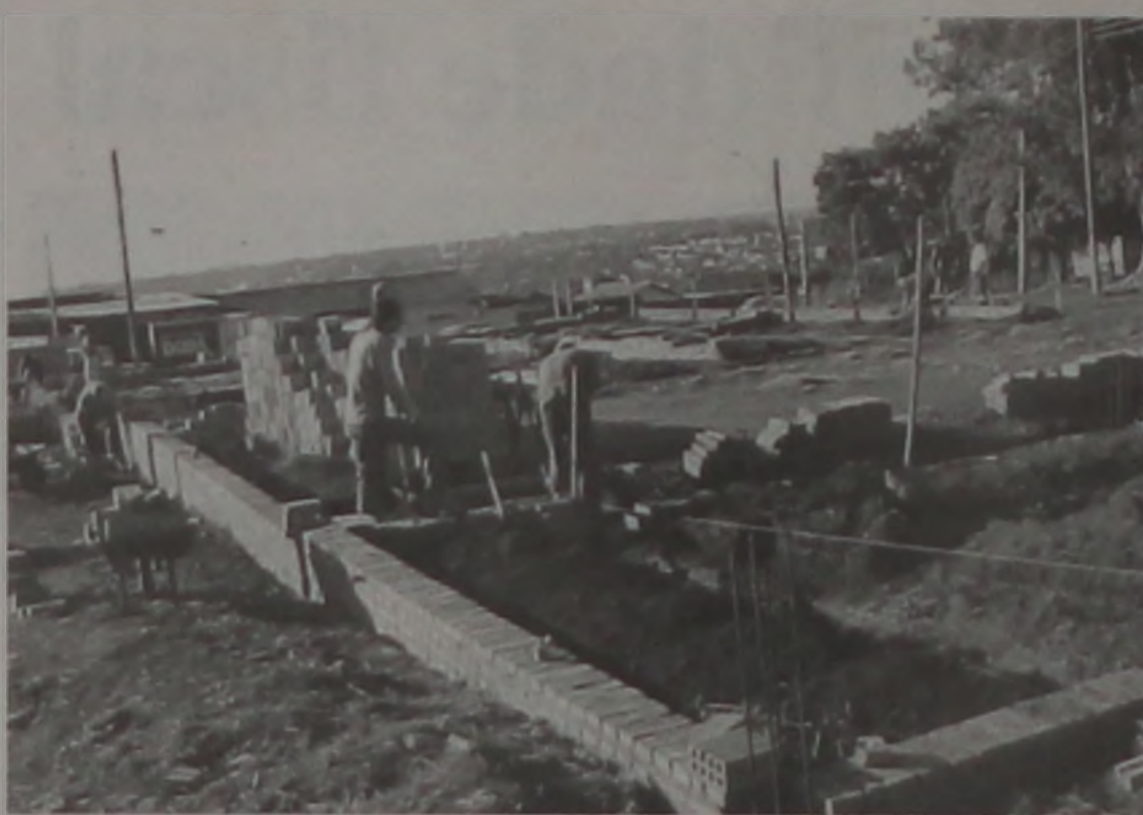
Construção em andamento da futura escola na V. Baccili
