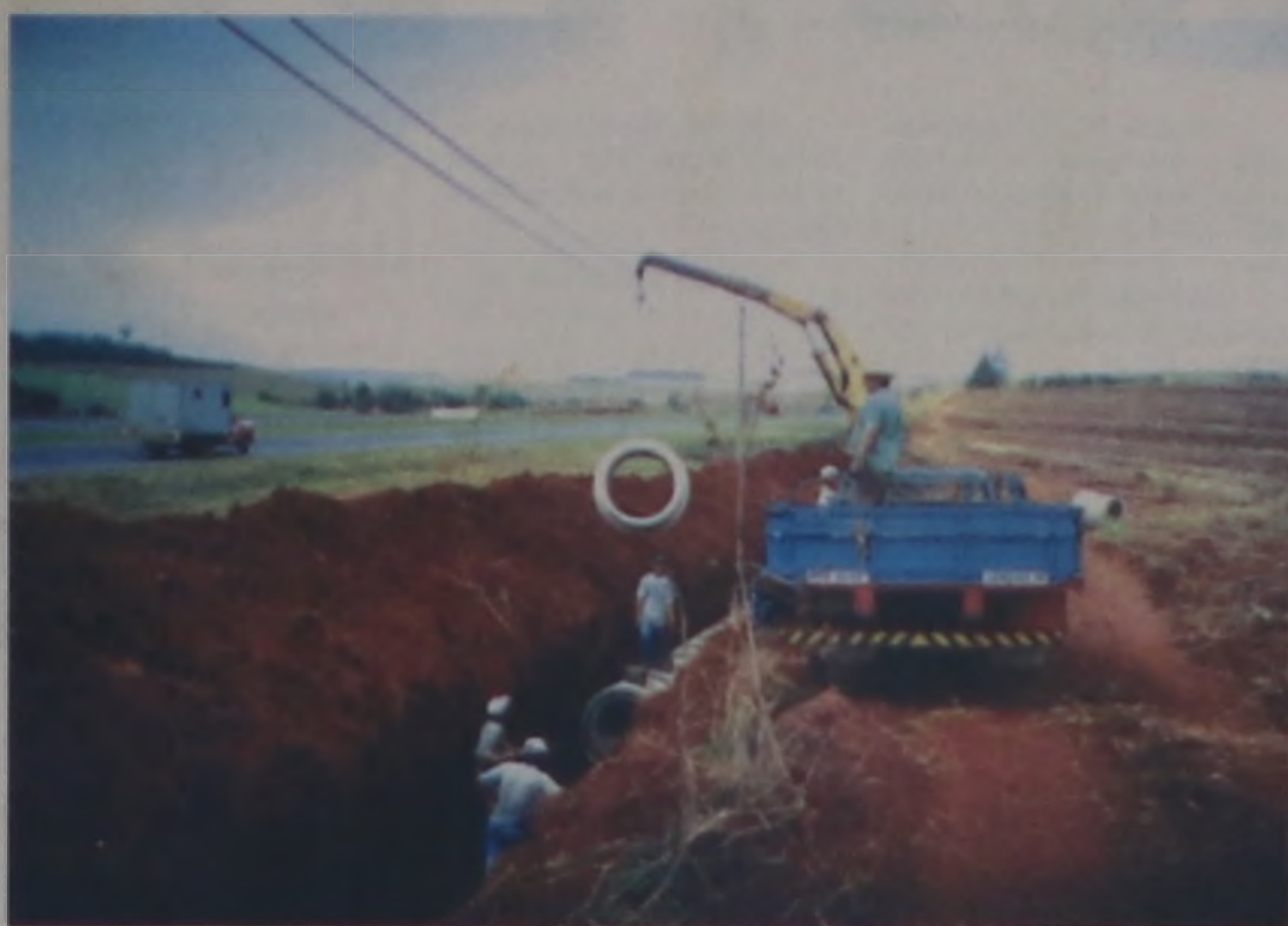
Já iniciada as obras da nova sede da Support
