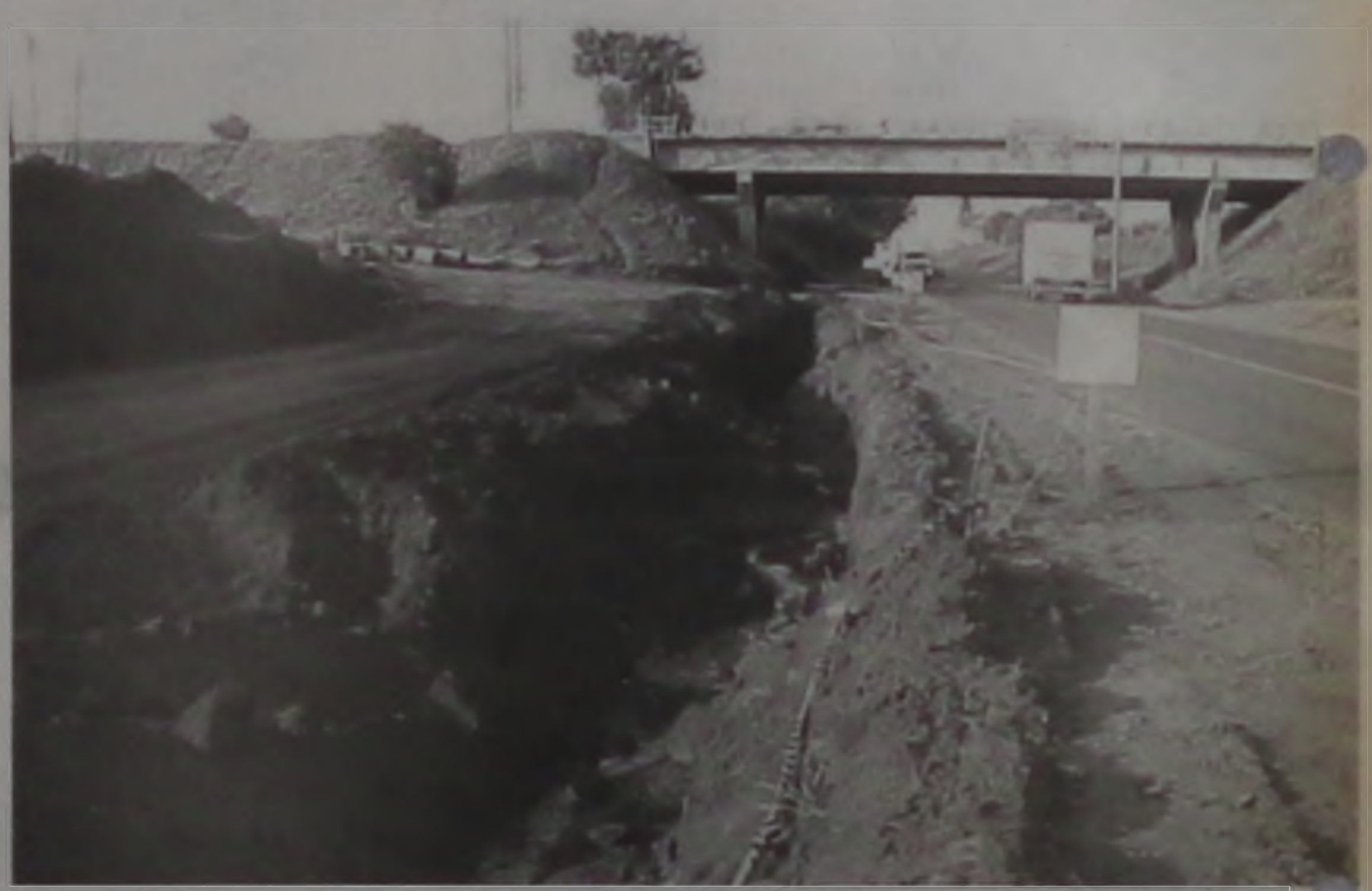
Está prevista a duplicação de rede de galerias pluviais
