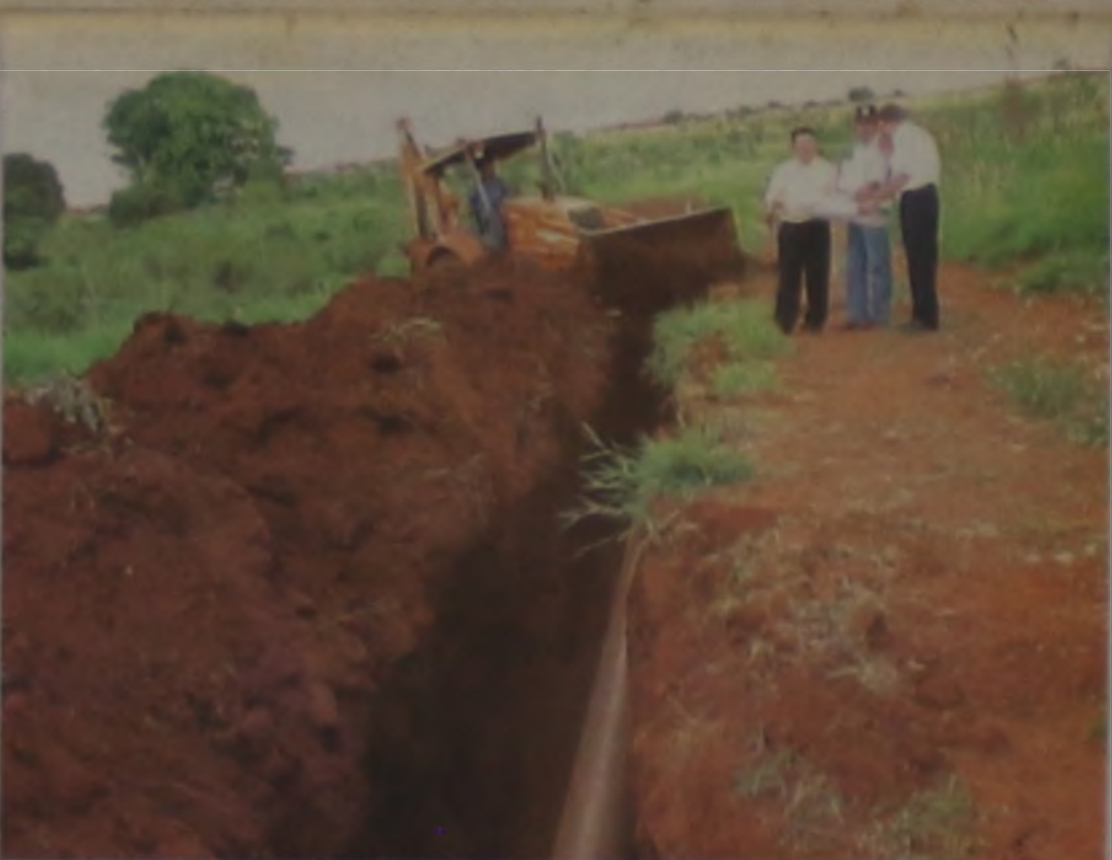
A construção de emissário deverá ter a sua primeira etapa concluída dentro 30 dias
