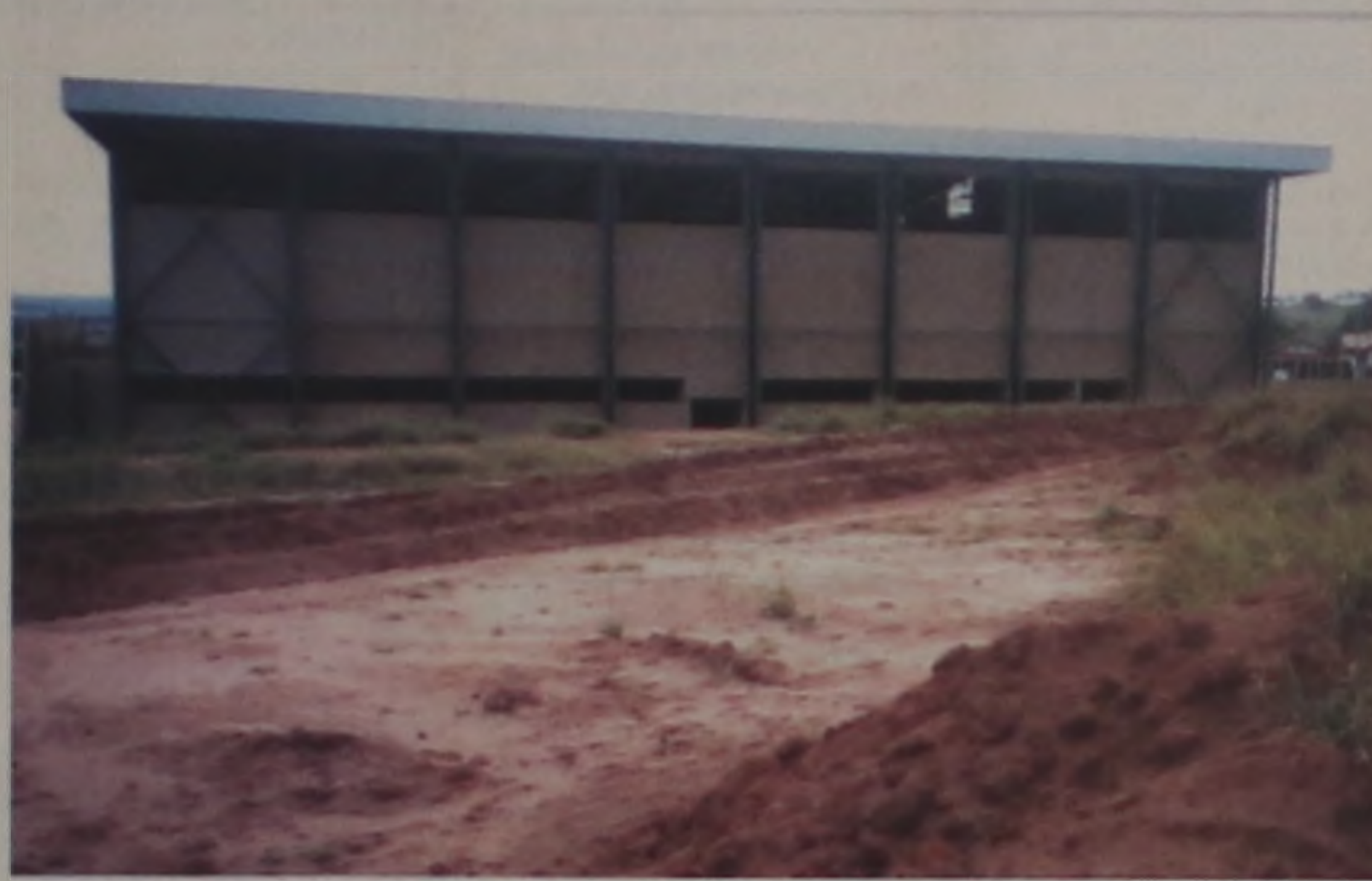
Início da construção do Centro do Trabalhador
