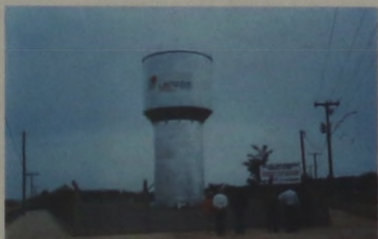
Reservatório na rua "Aristeu Rodrigues Sampaio" com capacidade para 1 milhão de litros
