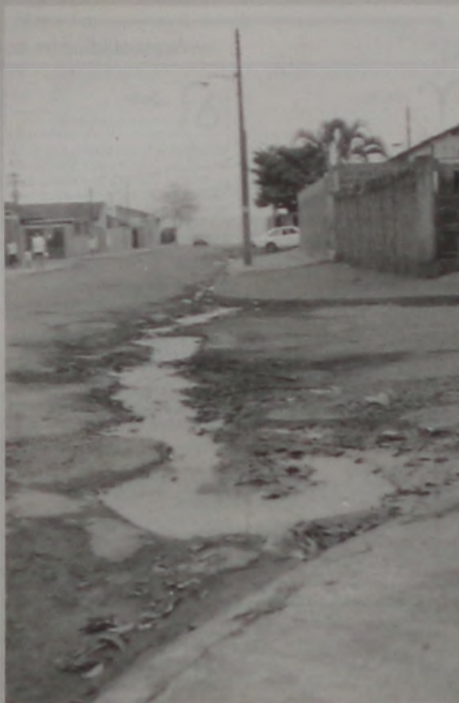
Asfalto e recapeamento fazem parte do PCM
