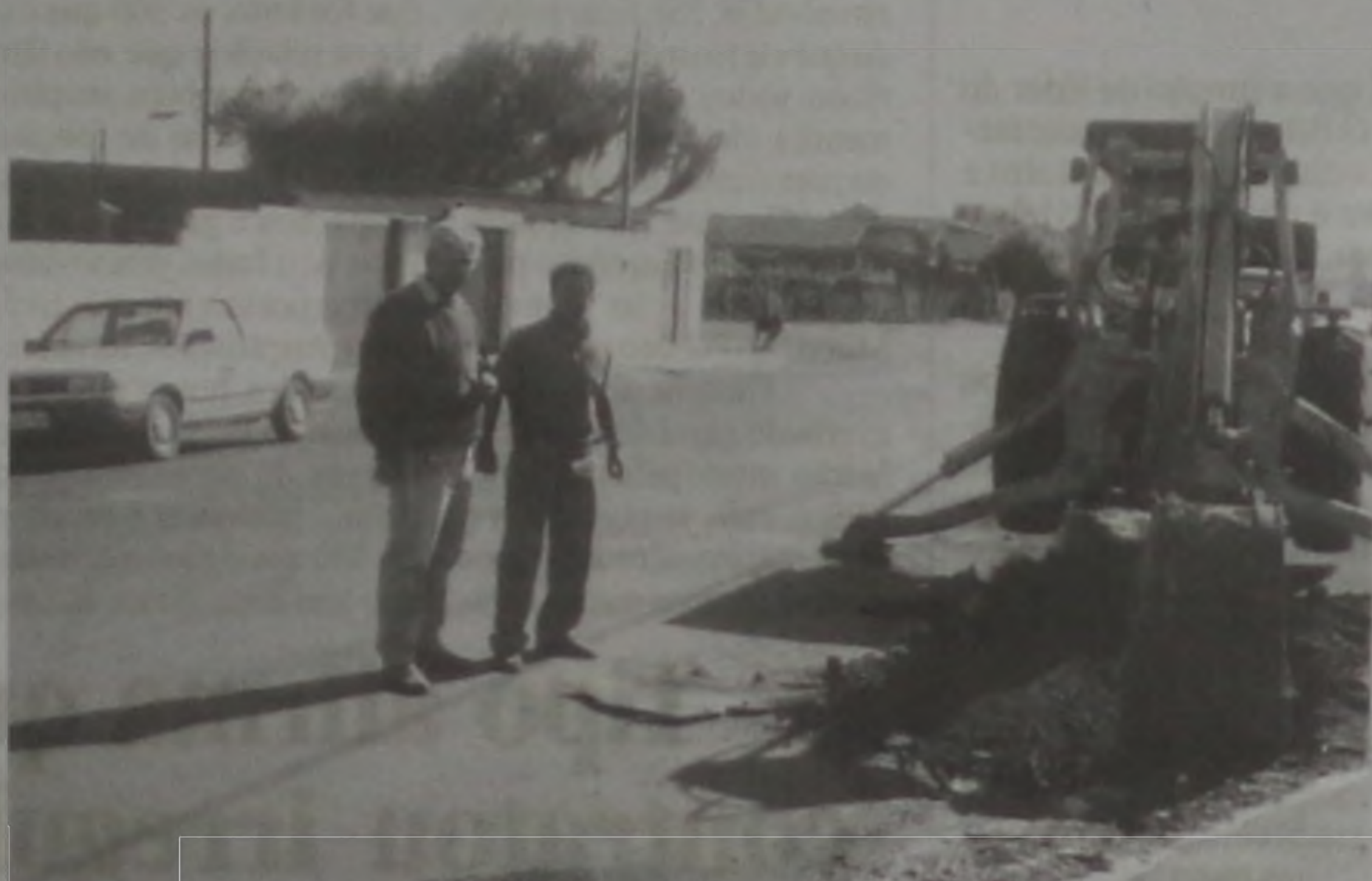
Manêzinho e Joner acompanham a implantação do sarjetão no bairro
