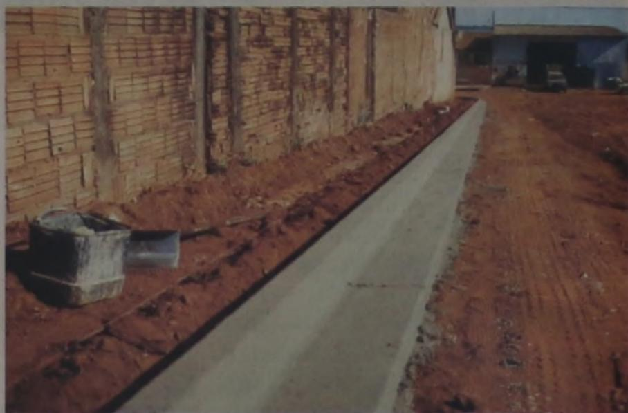
Além das guias e sarjetas o município instalou ainda galerias pluviais, que serviram de base para o asfalto
