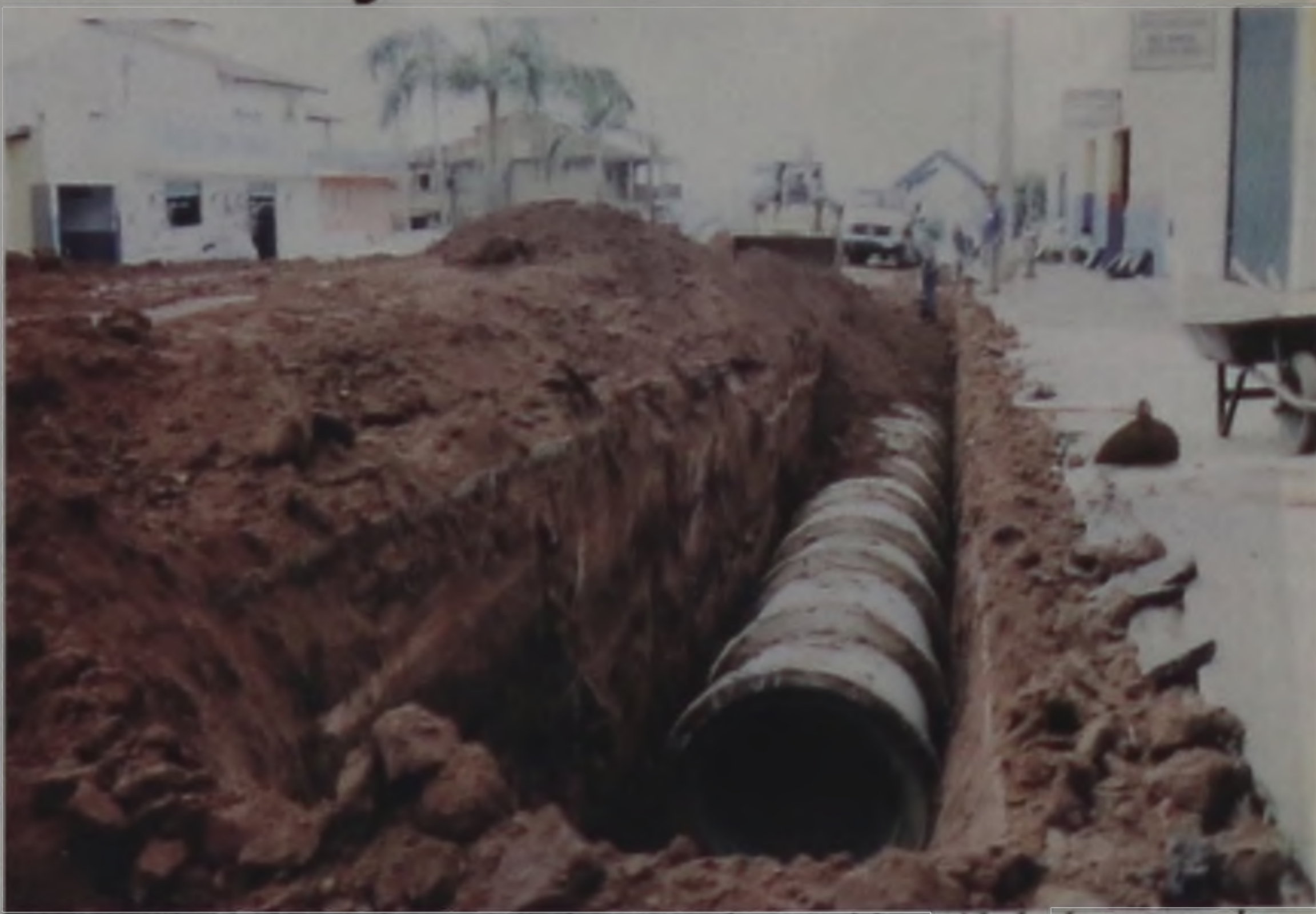
A Avenida Prefeito Jácomo Nicolau Paccola estará intertidada durante as obras
