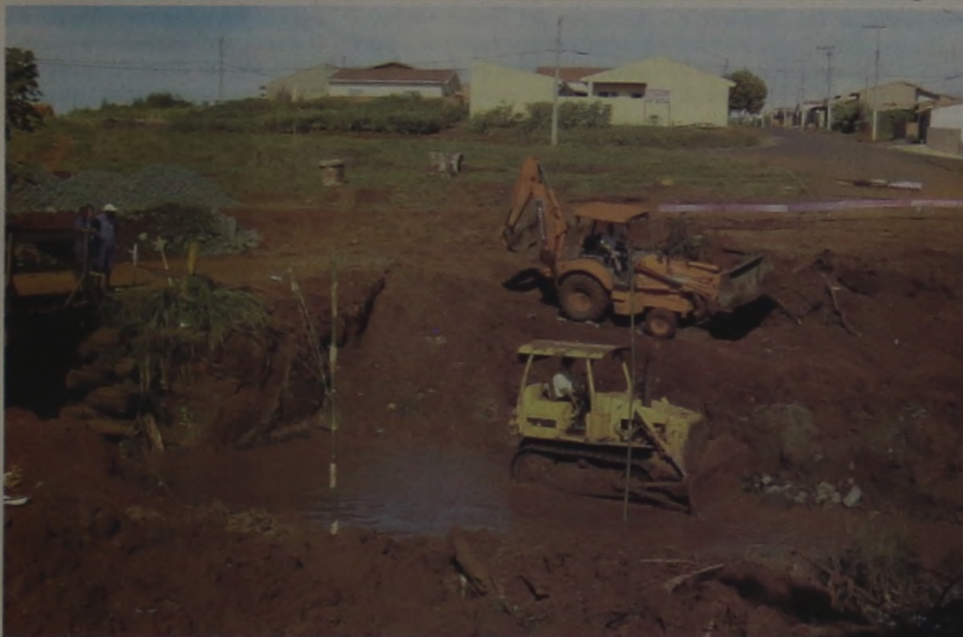
APONTE - As máquinas começaram as escavações para montar as cabeceiras da ponte que ligará a zona central da cidade do Jardim Príncipe. A nova passagem terá 12 metros de comprimento por 8,60 de largura e solucionará o problema do tráfego tanto de veículos como de pedestres. Página 7
