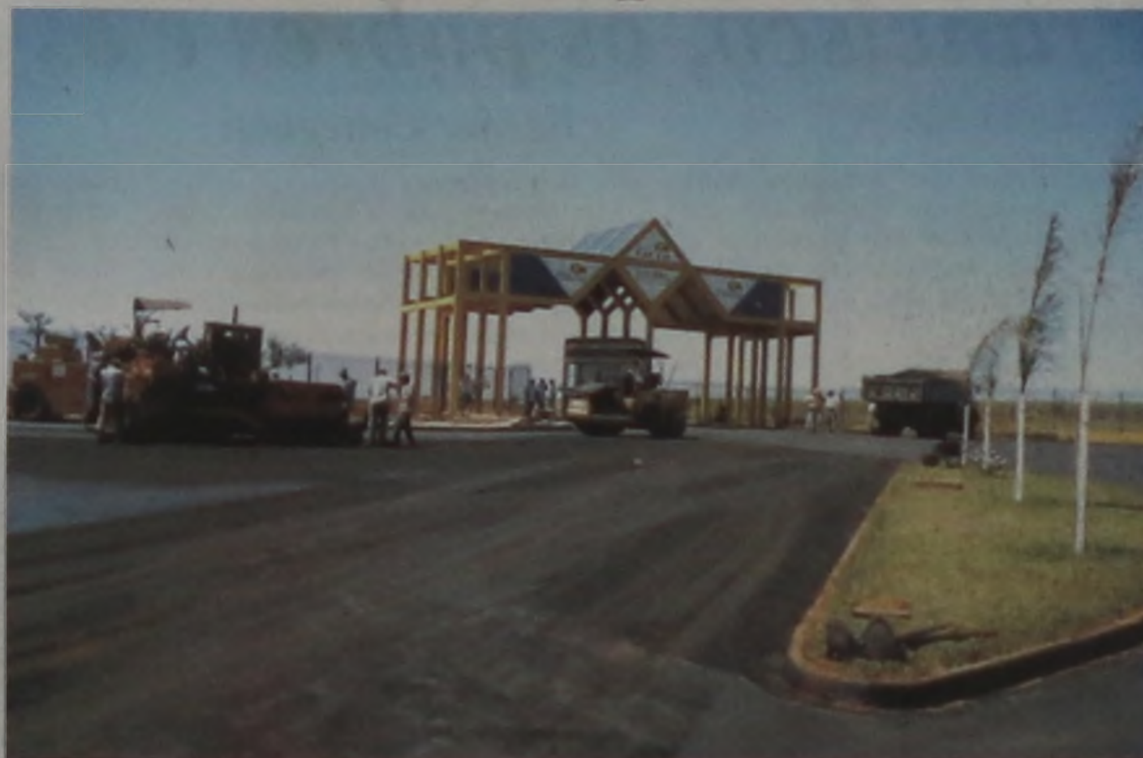
Foram investidos na obra R$ 220 mil em 14 mil metros quadrados de asfalto e 800 metros lineares de guias e sarjetas
