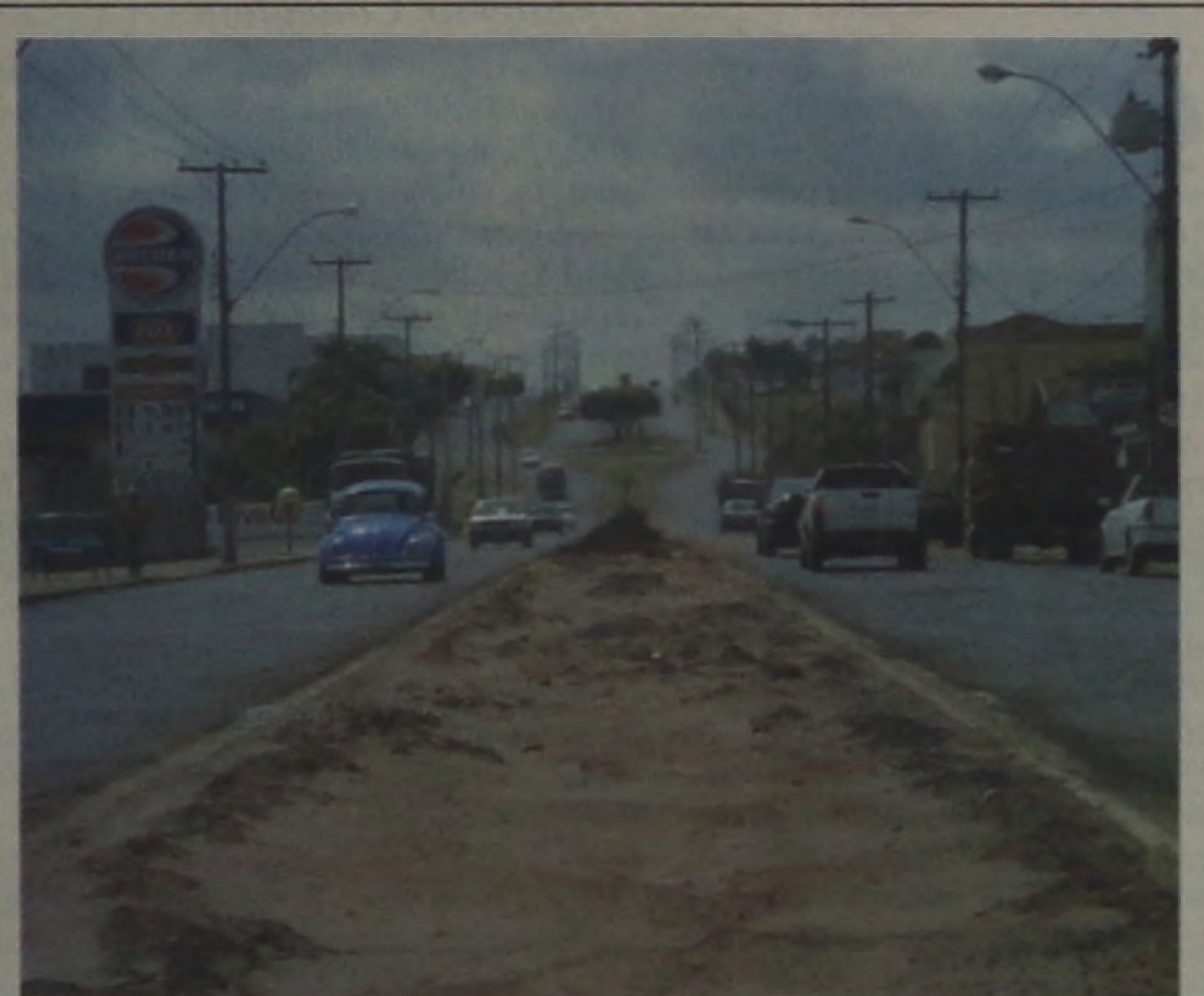
TAPETE A Administração Municipal anunciou nesta semana que vai recapar a Avenida Jácomo Nicolau Paccola, entre o viaduto sobre a rodovia Osny Matheus e a avenida Nações Unidas. Outra obra na infra-estrutura viária que começa nos próximos dias é a pavimentação de diversas ruas na Vila Antonieta II. Página 4
