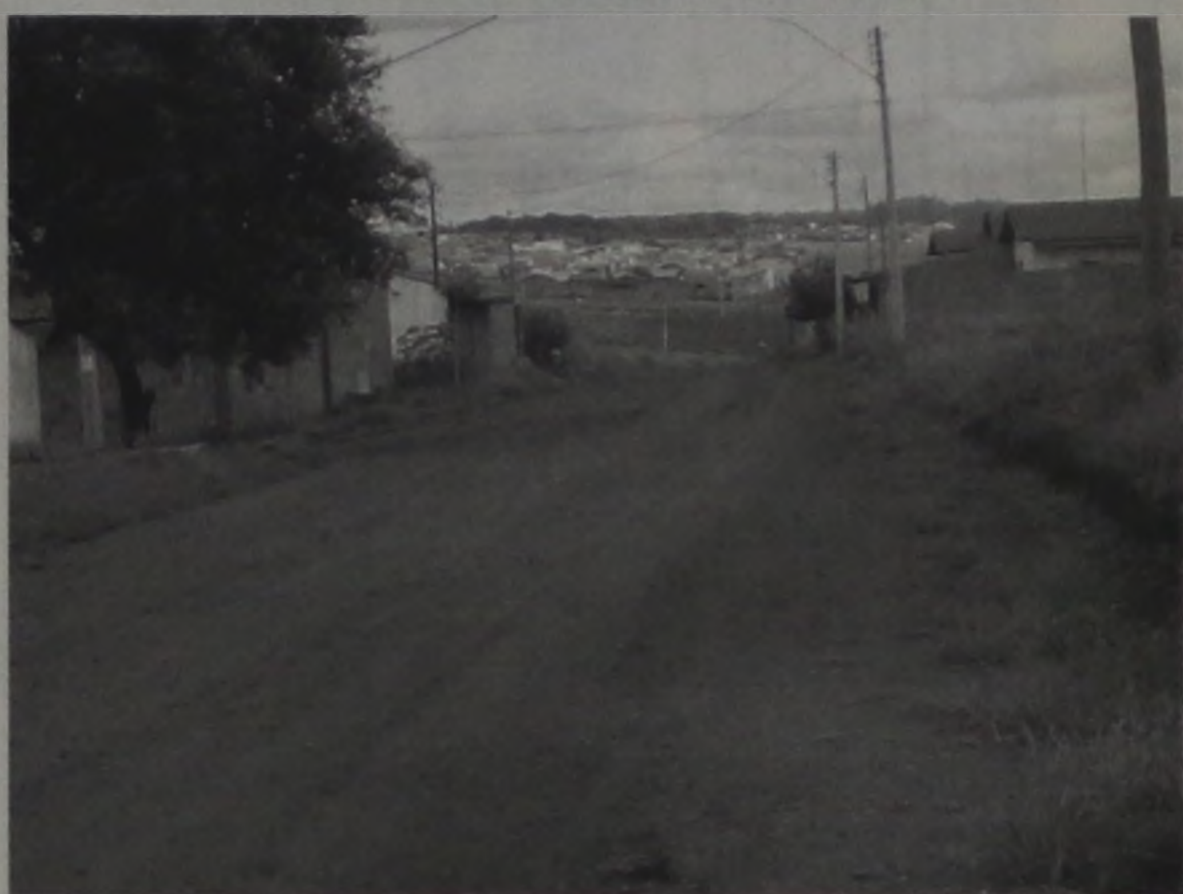
A rua Fortunato Zillo, na vila Antonieta II, que será pavimentada através do PCM
