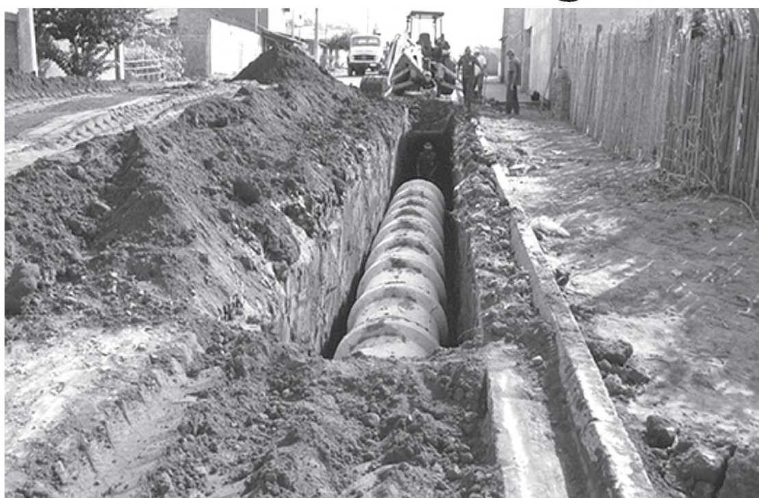
Máquinas trabalham na implantação de galerias no Caju
