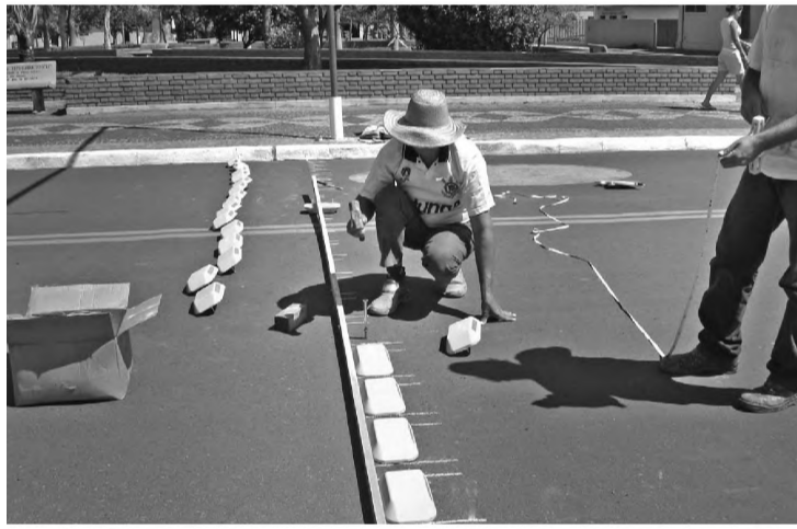
Funcionários instalam redutor de velocidade na rua 7 de Setembro
