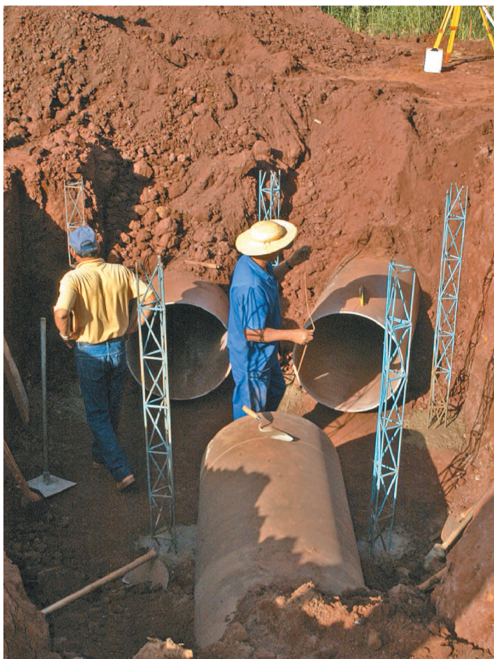
Funcionários do SAAE trabalham na colocação dos tubos
