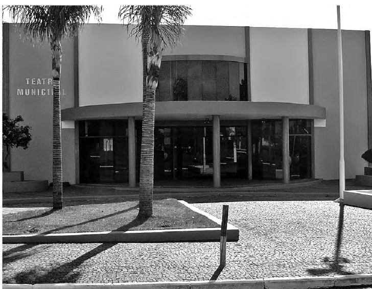
Teatro Municipal de Macatuba, que está passando por reforma
